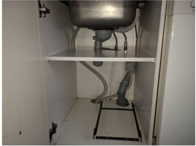
Allaskaappi. Aktiivisia vuotoja ei havaittu.
