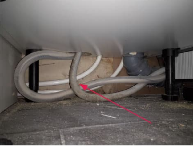
Allaskaapin alla havaittavissa uudempaa kipsilevyä. Vanhan kipsilevyn pinnassa on havaittavissa kosteusjälkiä. Jotka olisivat olleet syytä uusien vahinkokorjauksen yhteydessä.
