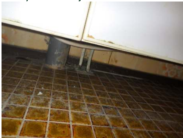
54. Havainnot käyttövesijohdot ja viemäriputket
