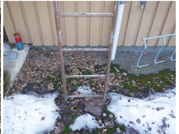
23. Talotikkaat alkavat läheltä maanpintaa
