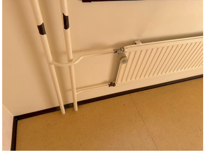
Kuva 8. Lämmönjakoputkiston ja pattereiden lähialueet tarkistettiin
