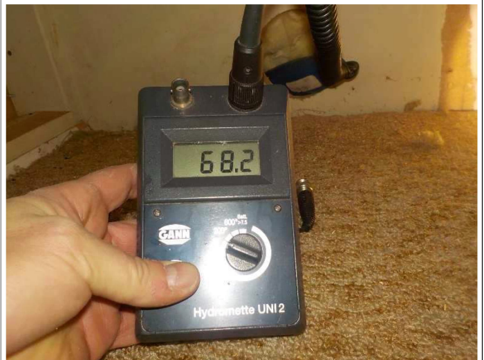
Väliseinän alimmaisten villaeristeiden suhteellisen kosteuden mittaus
