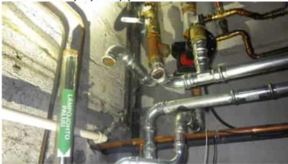
65. Putkiliitoksia irrotettu
