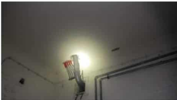
68. Uudehkoja vesiputkia ja viemäri
