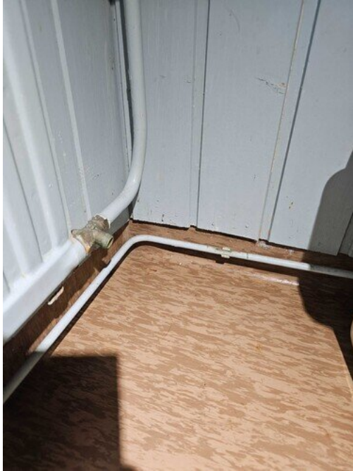
Kuva 11 Putkikannake irti ja vesiputki pääsee heilumaan.
