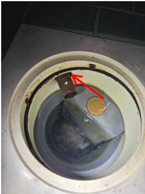
Kuva 6 Kaivon korokerenkaan läpi on johdettu kuparinen pyykkikoneen poistoputki. Kyseinen läpivienti ei ole tiivis.
