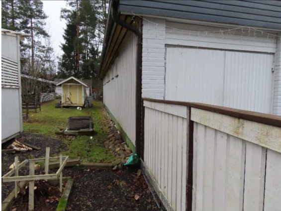
Julkisivut ovat kunnossa
