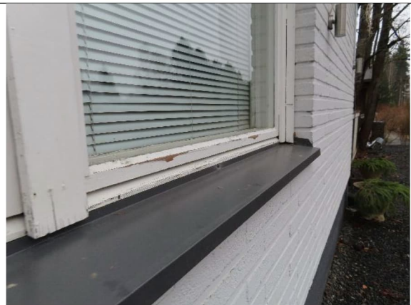
Ikkunat ja ikkunapellitykset ovat kunnossa
