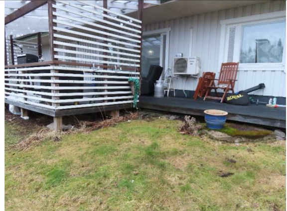
Julkisivut ovat kunnossa
