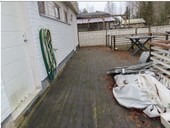
Julkisivut ovat kunnossa
