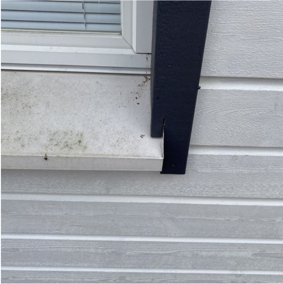
7. Yleiskuva: Ikkunoiden vesipellit ovat tarkastetuilta osin tiiviit.
