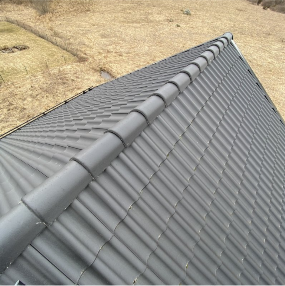
8. Yleiskuva: Kattotiilien kunnossa ei havaittu puutteita tarkastetuilta osin (ei halkeamia/rikkinäisiä tiiliä).
