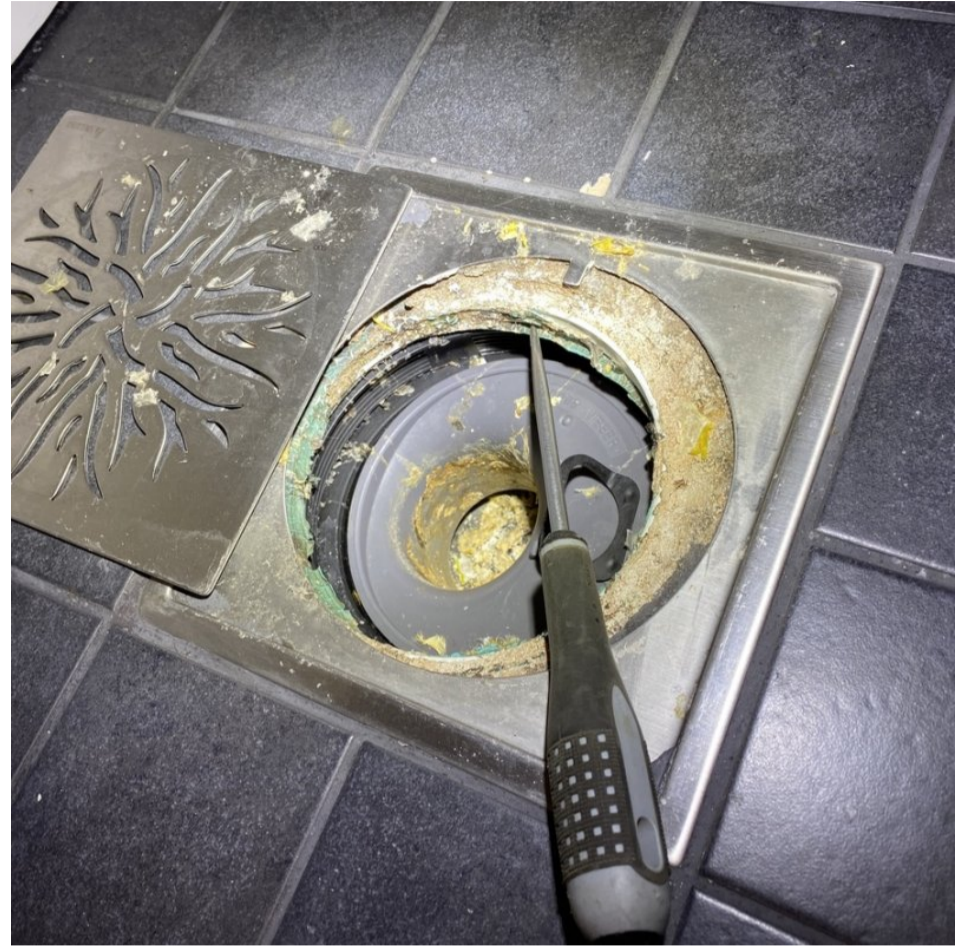
2. Yleiskuva: Erillisen pesuhuoneen lattiakaivosta havaittiin vahvikekangas kiristysrenkaan alta. Lattiakaivon asennus on näkyviltä osin nykyohjeiden mukainen.
