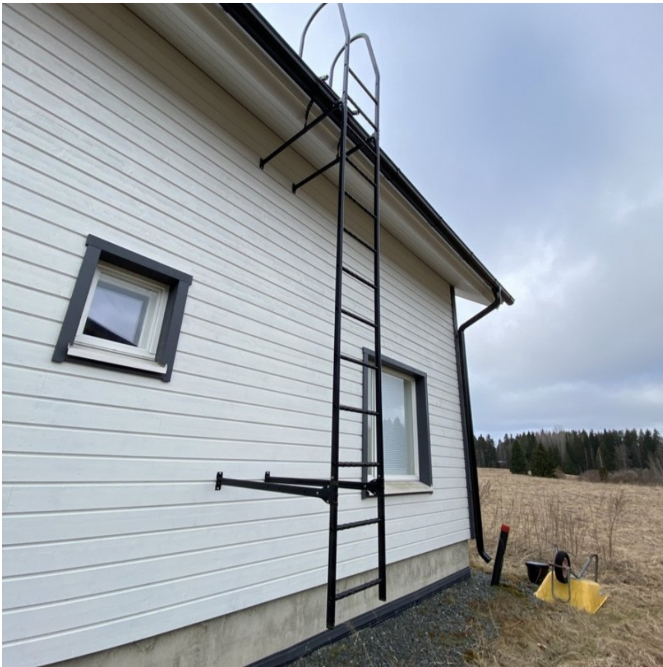
4. Yleiskuva: Seinätikkaiden asennuksessa ja kunnossa ei havaittu puutteita.
