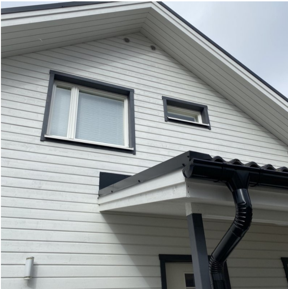
9. Yleiskuva: Etupihan puoleisen makuuhuoneen hätäpoistumisreitteinä toimii käytännössä sisäänkäyntikatos.
