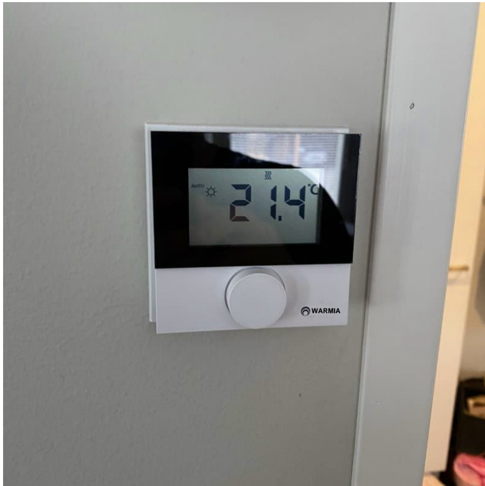
5. Yleiskuva: Lattialämmityksen tehokkuutta säädetään huone-/tilakohtaisista termostaateista.
