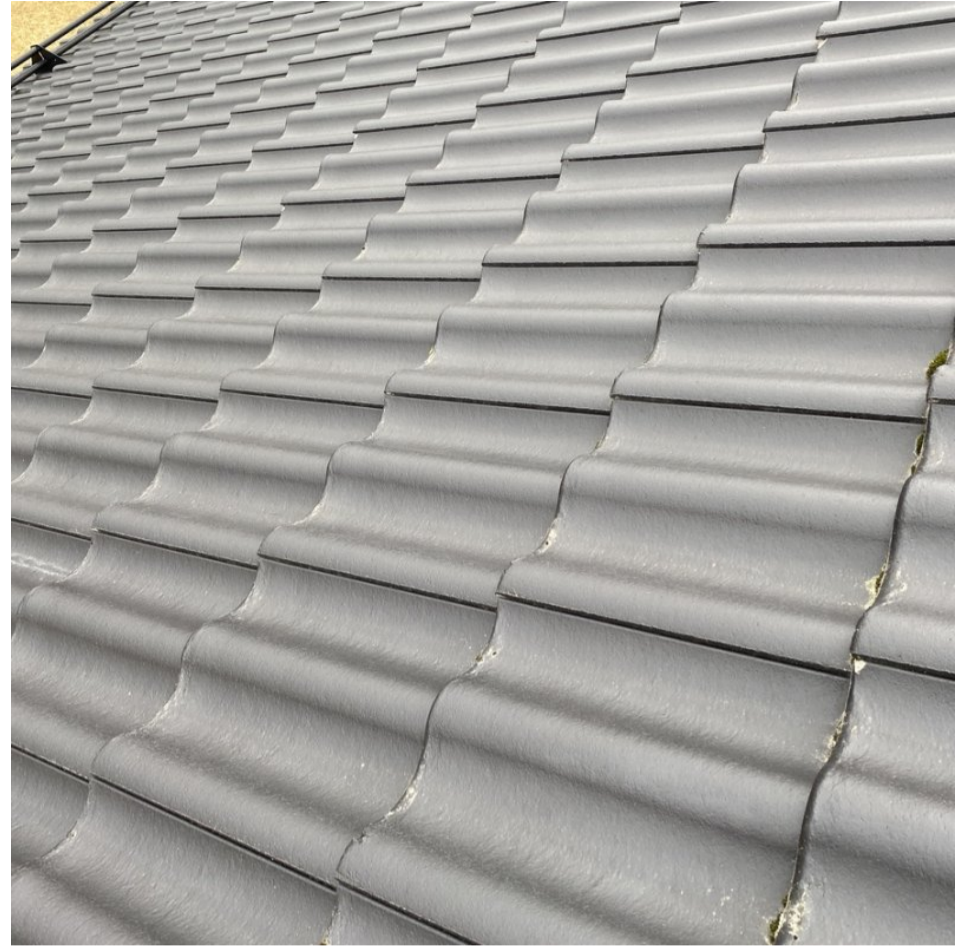
9. Yleiskuva: Katteen pinnoitteen kunnossa ei havaittu puutteita.
