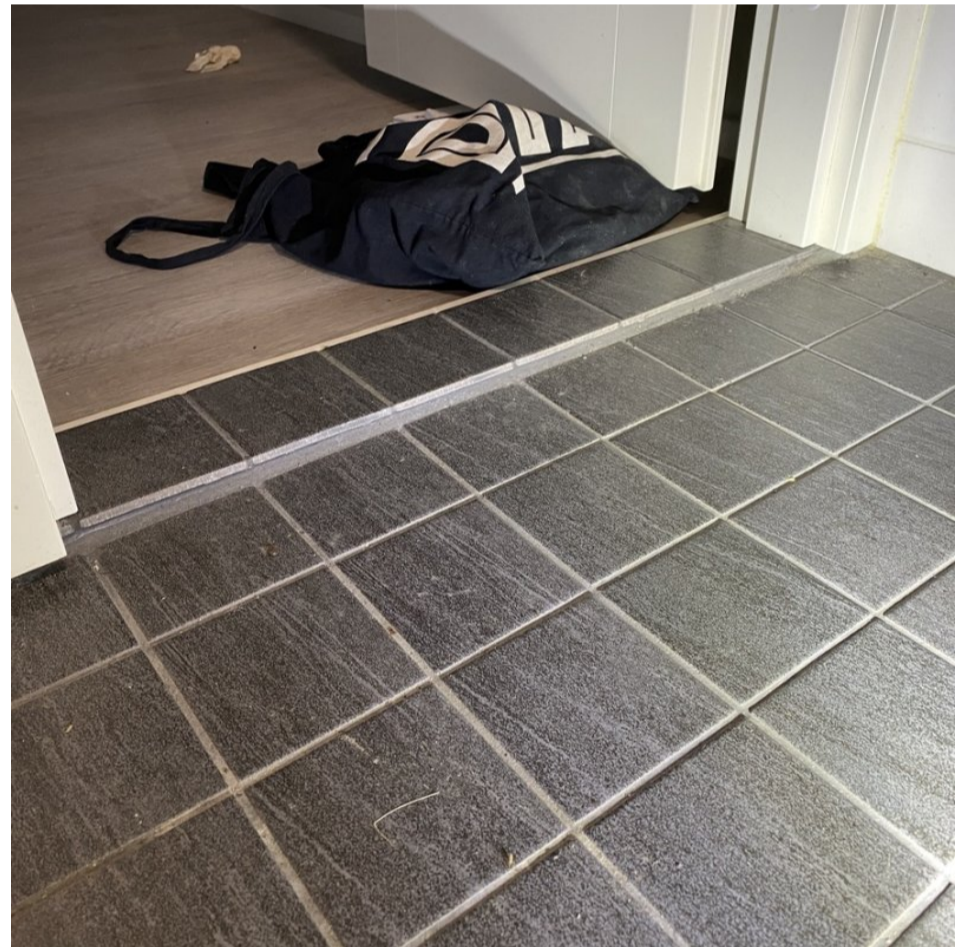
9. Yleiskuva: Alakerran pesuhuoneen ja kuivien tilojen välille on asennettu tulvakynnys. Kynnysten vesieristyksen ylösnostolla/tulvakynnyksellä pyritään estämään esimerkiksi tulvavesien tunkeutuminen kuiviin tiloihin.
