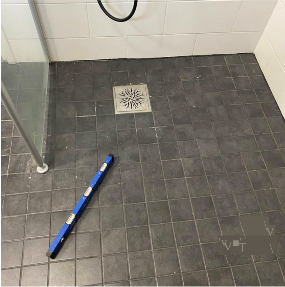
1. Yleiskuva: Erillisen pesuhuoneen lattian kaatojen toimintaa arvioitiin kaatopassilla. Lattian kaadoissa kohti lattiakaivoa ei havaittu mainittavia puutteita.
