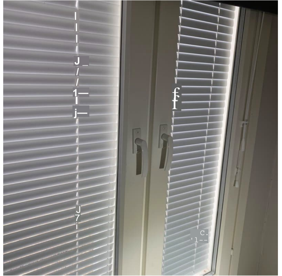
8. Yleiskuva: Yläkerran makuuhuoneiden ikkunoihin on asennettu kiintokahvat, jotta hätätilanteessa ikkunat saadaan nopeasti auki niitä rikkomatta (hätäpoistuminen).
