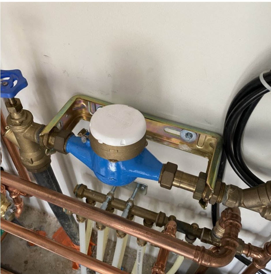
4. Yleiskuva: Vesimittarin kannakoinnissa ei havaittu puutteita.
