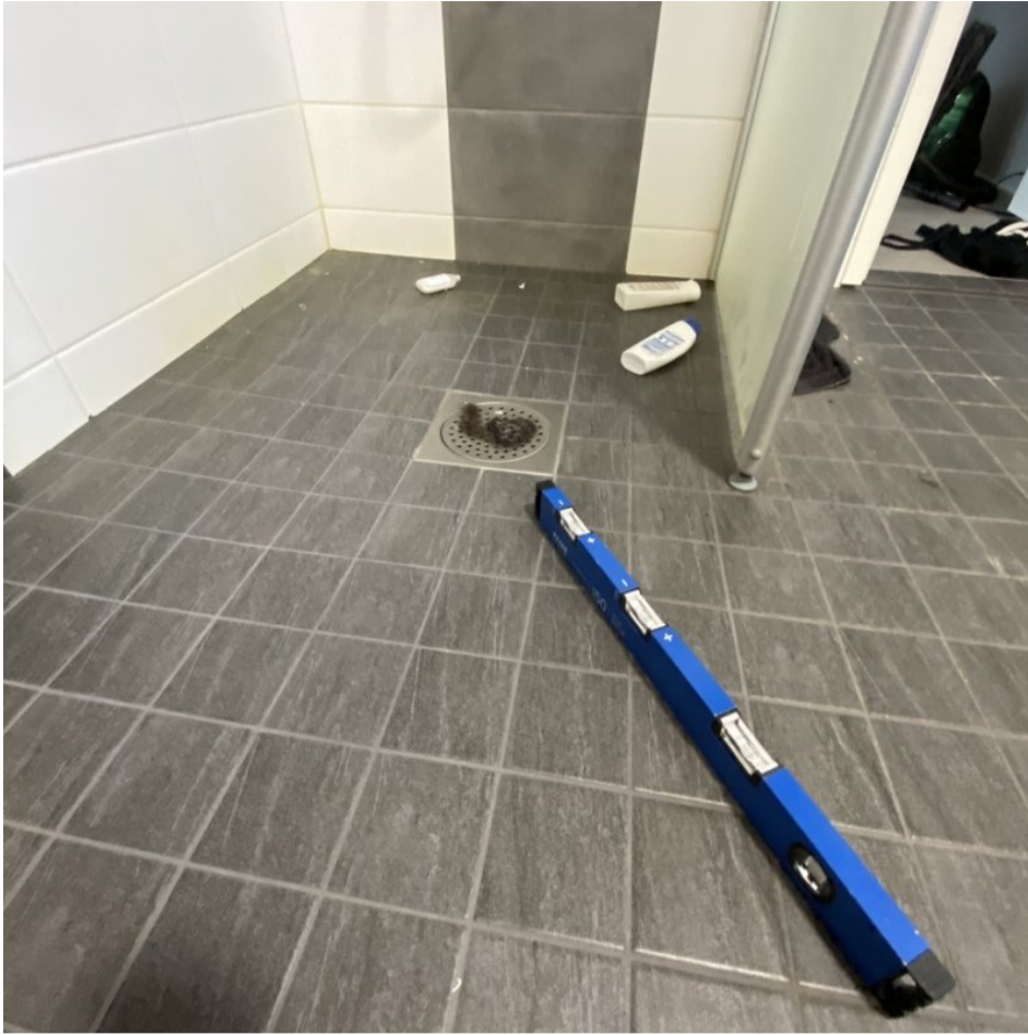
6. Yleiskuva: Alakerran pesuhuoneen lattian kaatojen toimintaa arvioitiin kaatopassilla. Lattian kaadoissa kohti lattiakaivoa ei havaittu mainittavia puutteita.
