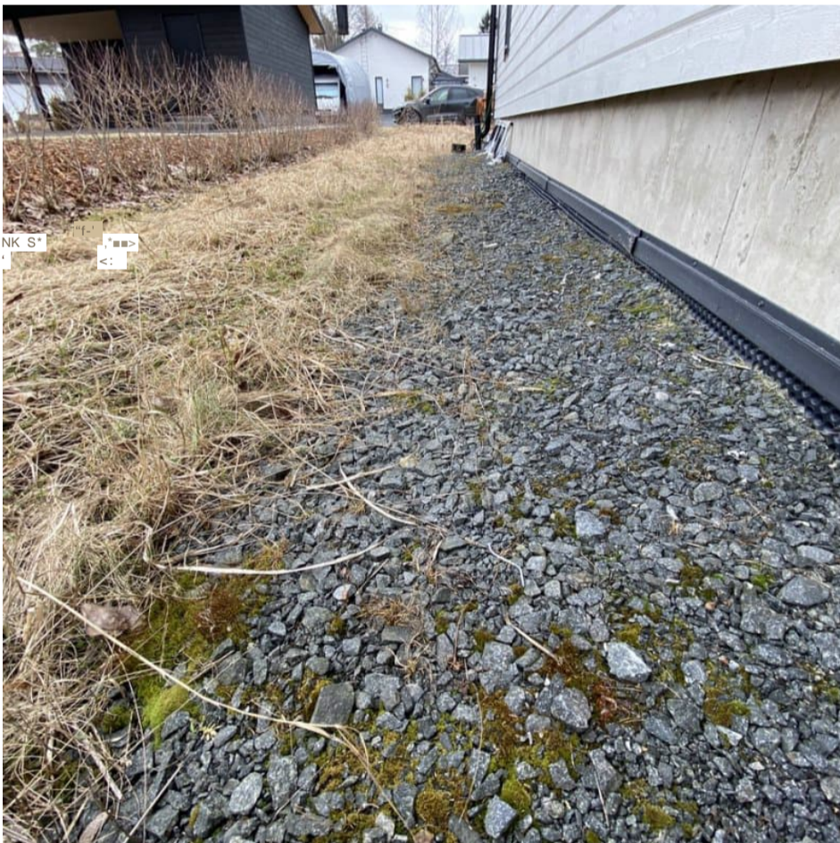
9. Yleiskuva: Maaston kaltevuuksissa rakennuksen vierellä ei havaittu mainittavia puutteita. Suositusten mukaan rakennuksen viereisen maanpinnan tulee viettää poispäin rakennuksesta 1:20 kaltevuudella kolmen metrin etäisyydellä.
