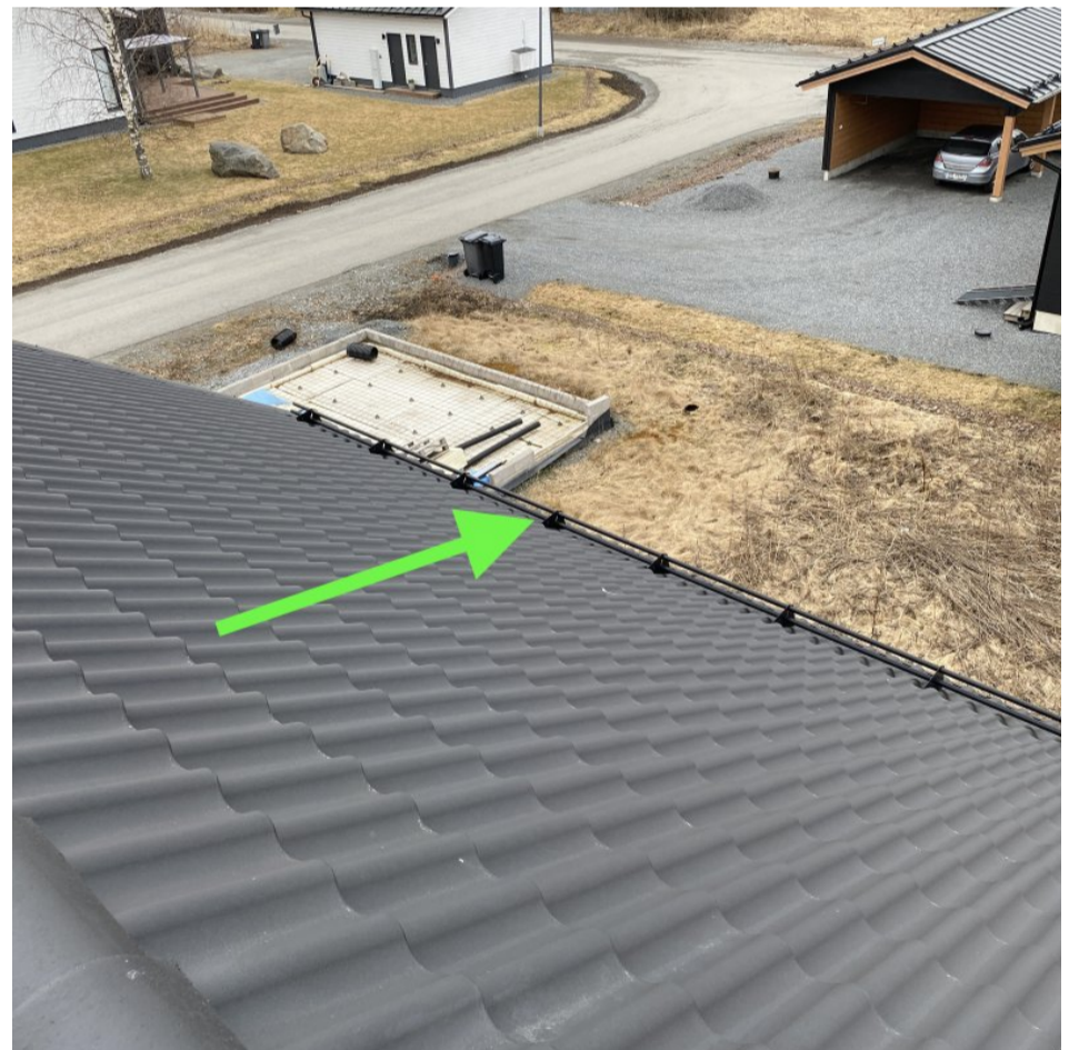
7. Yleiskuva: Vesikatolle on asennettu lumiesteet molempien lappeiden koko leveydelle.
