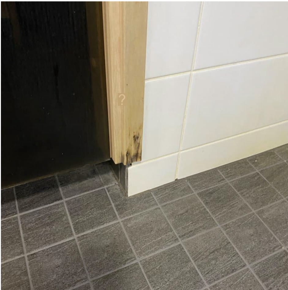
8. Huomio: Saunan ovirakenteet ovat korkean kosteusrasituksen alueella, jonka vuoksi niiden säännöllinen huolto/uusiminen on tärkeää (kestävyyden varmistaminen).
