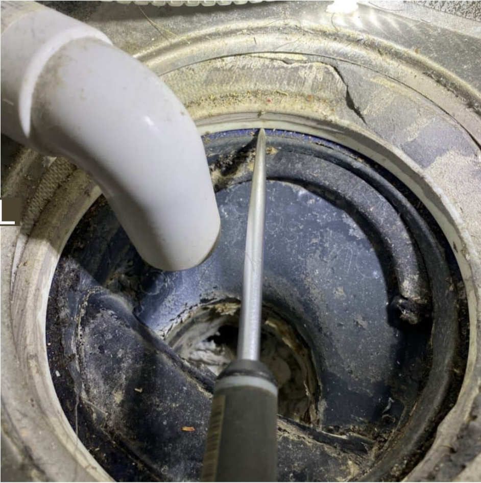
9. Yleiskuva: Erillisen WC-tilan lattiakaivosta havaittiin kiristysrengas ja sen alta vahvikekangas (nykyaikaiset vedeneristeet).
