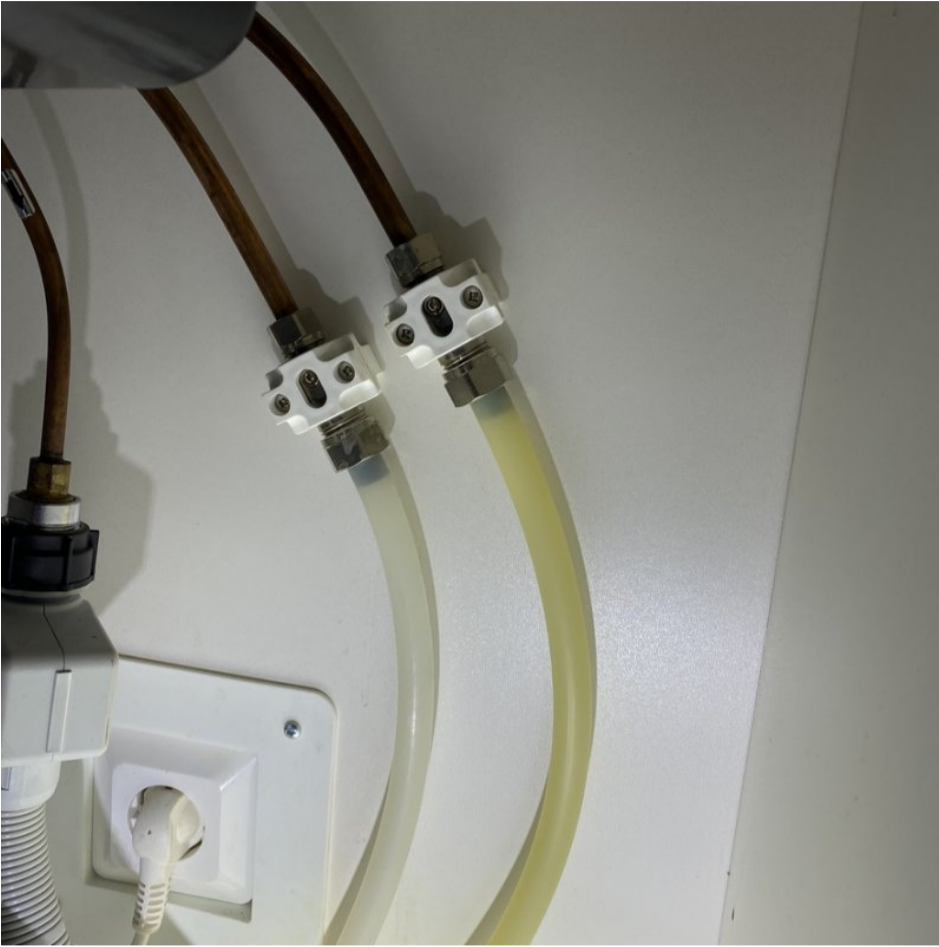
2. Yleiskuva: Käyttövesiputkien kannakoinneissa ei havaittu puutteita näkyviltä osin.
