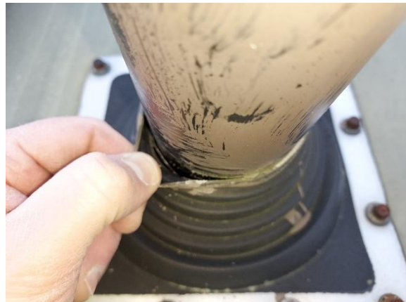
Viemärin tuuletusputken läpivientikappaleen kiristyspanta puuttuu. Läpiviennin mahdollista epätiiveyttä ja mahdollisia vaurioita yläpohjassa ei päästy tutkimaan yläpohjan kulkutien puuttumisen vuoksi.
