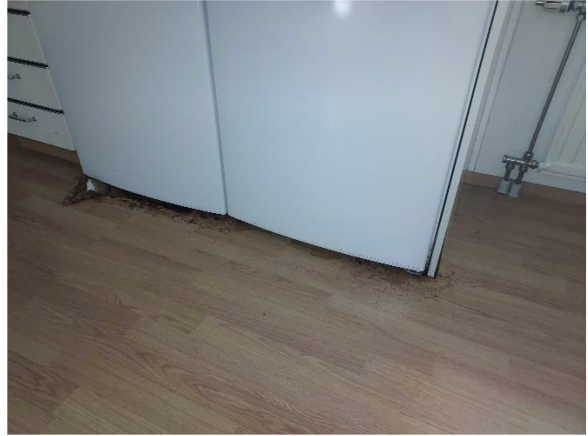
Keittiössä on kylmälaitteiden sulamisen seurauksena kosteusvaurioita lattiassa ja kalustelevyissä
