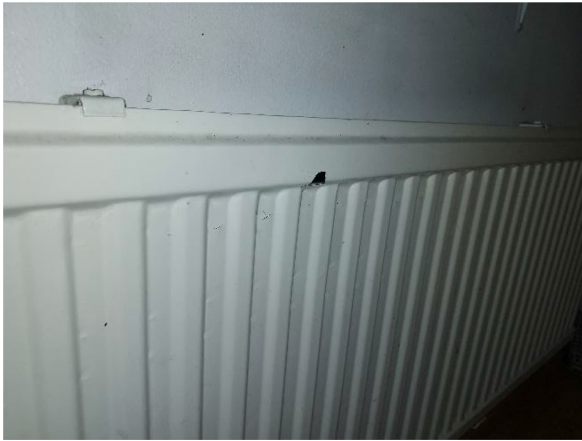
Useassa vesikiertoisessa patterissa on viitteitä patterin jäätymisvaurioista
