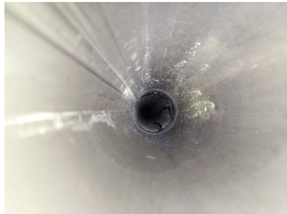
Öljykattilan sisäteräspiipun sisäpinnoilla oli vesinoroja ja piipun pohjalla havaittu kimallus viittaa irtoveteen piipun pohjalla
