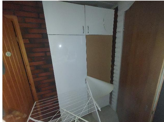
Khh:n kaapistojen korkeakiilto-pinnoitteet irtoilevat kaappilevyjen pinnasta. Ilmiö on viite epäedullisista sisäilmaston olosuhteista (kaapit on suunniteltu kuiviin ja lämpimiin sisätiloihin)
