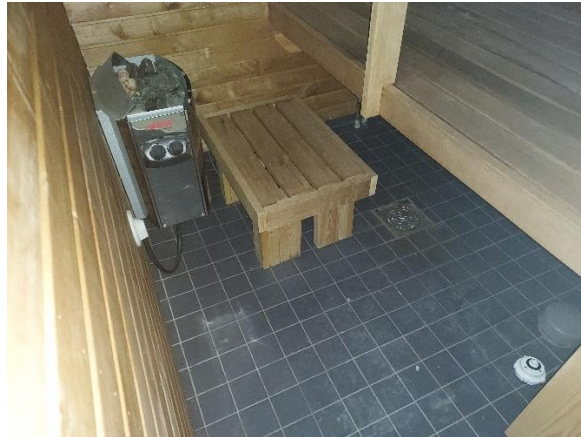
Saunassa mitattiin kohonneita kosteusarvoja lattiapinnalla ja seinien alaosissa
