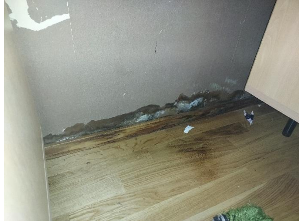
Päädystä sijaitsevan makuuhuoneen päätyseinän alaosa ja lattia päätyseinän välittömässä läheisyydessä on kosteus- ja mikrobivaurioitunut
