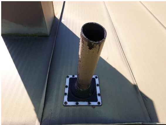
Viemärin tuuletusputken läpivientikappaleen kiristyspanta puuttuu. Läpiviennin mahdollista epätiiveyttä ja mahdollisia vaurioita yläpohjassa ei päästy tutkimaan yläpohjan kulkutien puuttumisen vuoksi.
