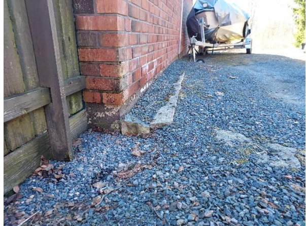
Päädystä naapurin piha kallistaa kohti rakennuksen päätyseinää ja sokkelirakenteessa sekä alimmissa julkisivumuurauksen tiilissä on kosteuden nousua havaittavissa. Havainto viittaa maakosteusrasitukseen.
