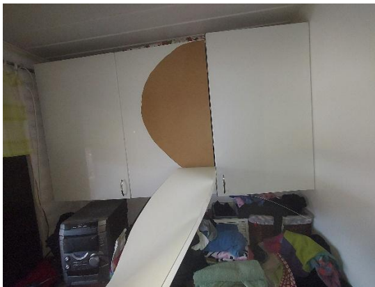
Khh:n kaapistojen korkeakiilto-pinnoitteet irtoilevat kaappilevyjen pinnasta. Ilmiö on viite epäedullisista sisäilmaston olosuhteista (kaapit on suunniteltu kuiviin ja lämpimiin sisätiloihin)
