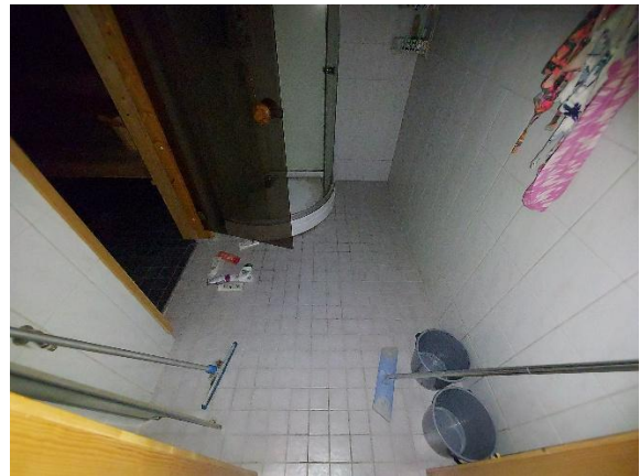
Pesuhuoneessa mitattiin kohonneita kosteusarvoja lattiapinnalla ja seinien alaosissa
