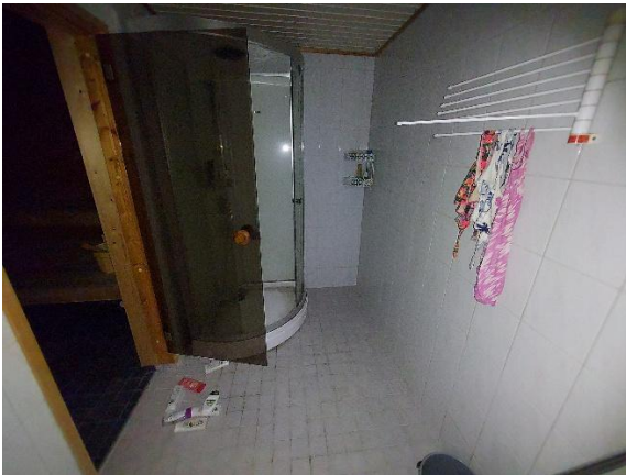
Pesuhuoneessa mitattiin kohonneita kosteusarvoja lattiapinnalla ja seinien alaosissa
