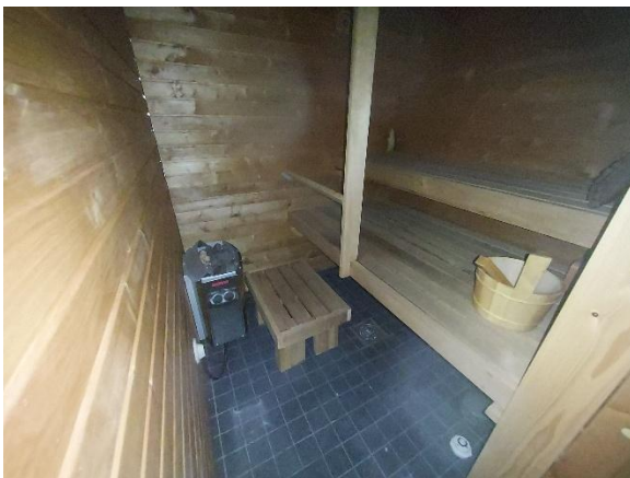
Saunassa mitattiin kohonneita kosteusarvoja lattiapinnalla ja seinien alaosissa
