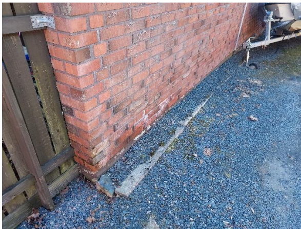
Päädystä naapurin piha kallistaa kohti rakennuksen päätyseinää ja sokkelirakenteessa sekä alimmissa julkisivumuurauksen tiilissä on kosteuden nousua havaittavissa. Havainto viittaa maakosteusrasitukseen.
