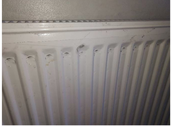
Useassa vesikiertoisessa patterissa on viitteitä patterin jäätymisvaurioista
