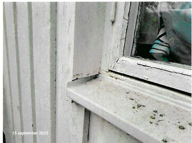
Närbild fönster. Fönsterplåtarna är otätt anslutna i kortsidorna. Rekommenderas att man tätar dessa med mjukfog ämnad för utomhusbruk.
