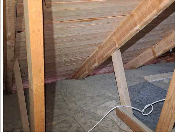
22. Yläpohjattilan tuuletusrako
