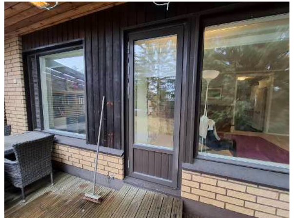
12. Terrassin ovi ja ikkunat
