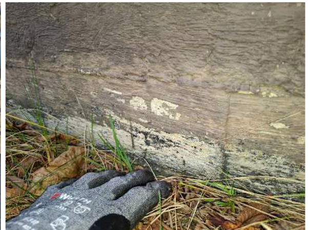
2. Perusmuurin vedeneristysnä toimiva bitumisively
