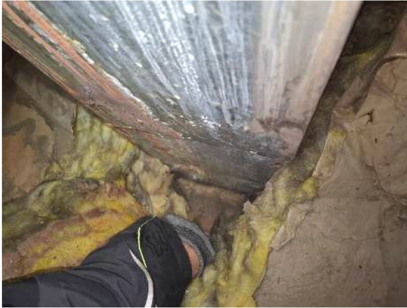
21. Hornin läpiviennin valumajäljet
