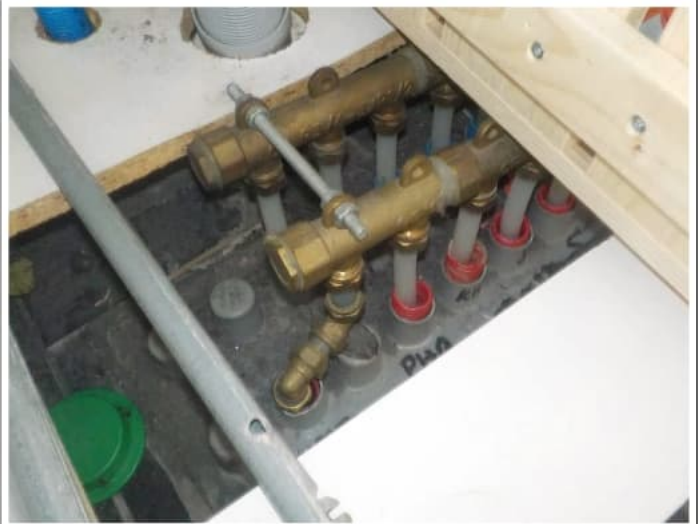
Kodinhuoltohuoneen jakotukit.
