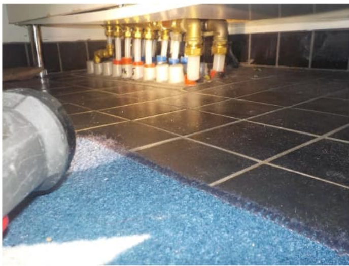
Kodinhuoltohuoneen jakotukit.
