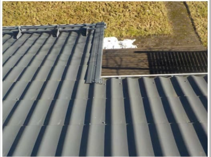
Pidemmälle ulottuvan lappeen liitoskohta.
