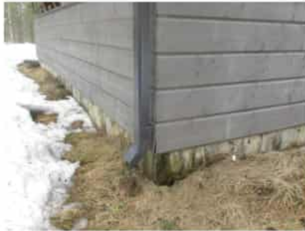
Kuva 1a. Sokkelia, rakennuksen vierustaa ja katto-vesien ohjausta.
