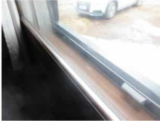
Kuva 3a. Ikkunatyyppi. Ikkunoiden väleissä ei pistokokein tarkastettuna havaittu kosteusjälkiä.
