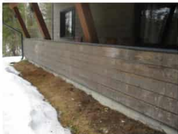
Kuva 1c. Maanpinnan viettojen tarkastelua takasivulla.
