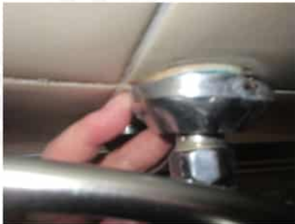
Kuva 5.4c. Hanakulman läpiviennit olivat tiivistetty.
