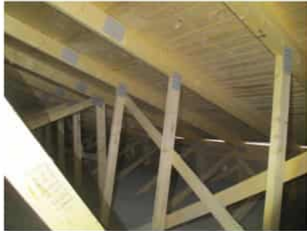
Kuva 4d. Yläpohjaa. Tuloilmavirtaus tapahtuu räystäsrakenteista.
