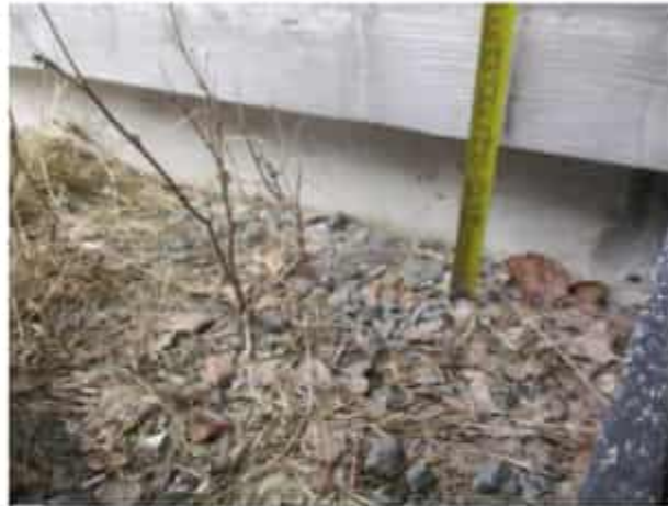
Kuva 1d. Sokkelin ja alasidepuun korkoasema tarkastelua.
