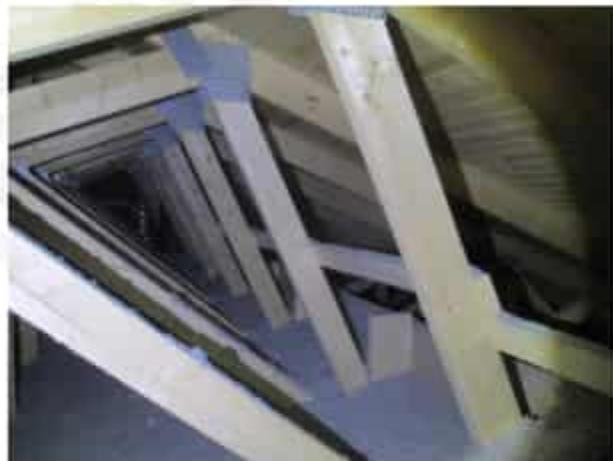
Kuva 4f. Yleiskuvaa yläpohjasta.
