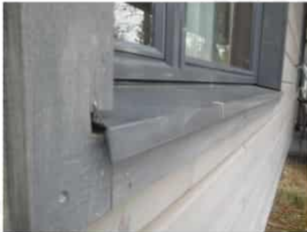
Kuva 3b. Vesipellitystä.
