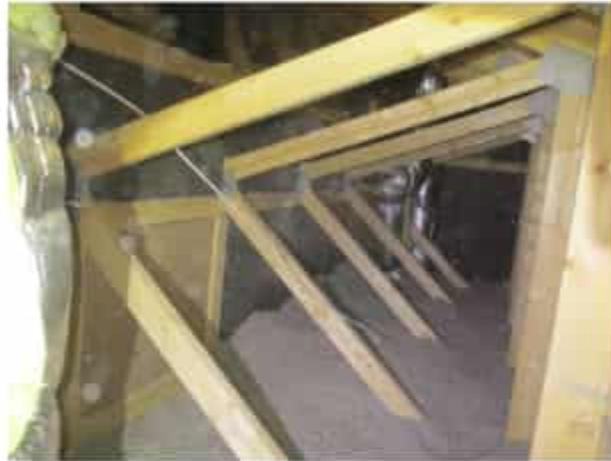
Kuva 4g. Ilmanvaihtokanavat olivat eristetty.
