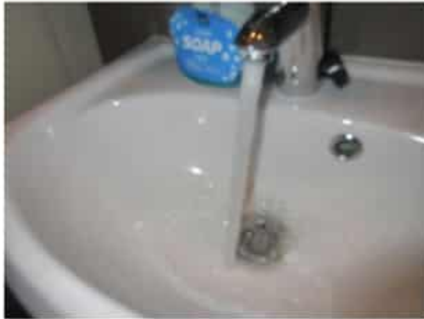
Kuva 9b. Vedenvirtaaman koestus ja allasviemäriin tiiveyden testaus.
