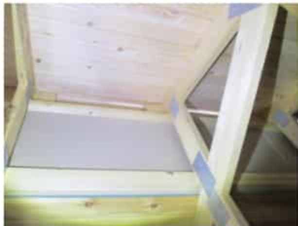
Kuva 4e. Poistoilman virtausreitti ylemmän lappeen yläosassa.
