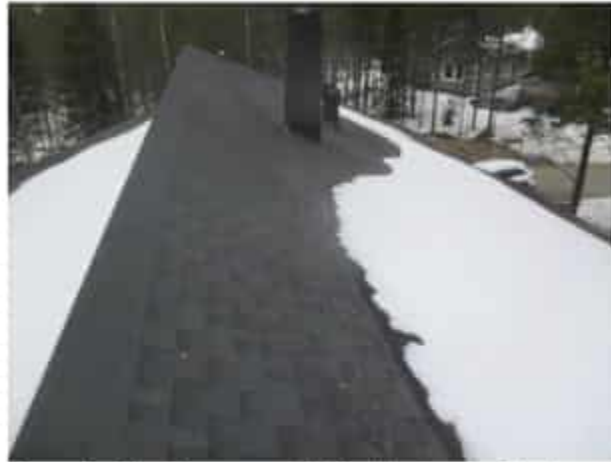
Kuva 4a. Yleiskuvaa vesikatteelta. Lumipeite hankaloitti hieman katteen tarkastusta.
