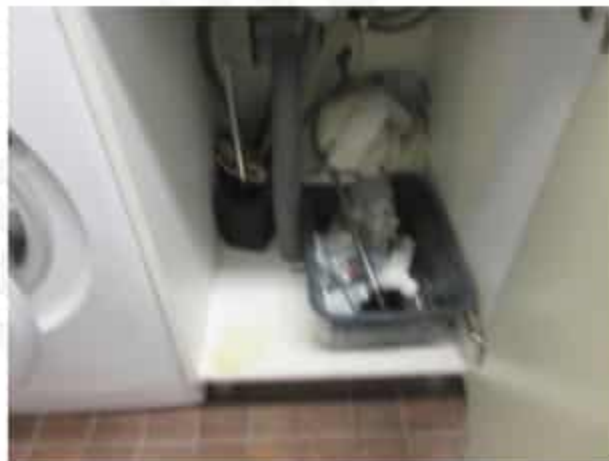
Kuva 5.6b. Allaskaapissa ei havaittu akuutteja vuotoja.
