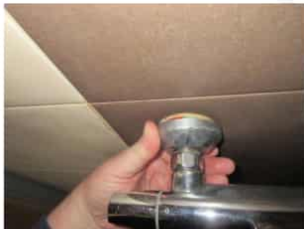
Kuva 5b. Hanakulman läpiviennit.
