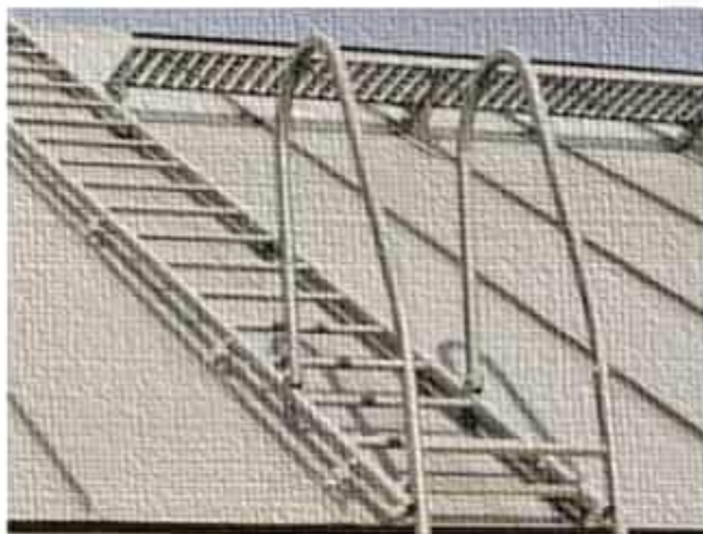
Talotikkaiden ankkurointi rakenteeseen.
