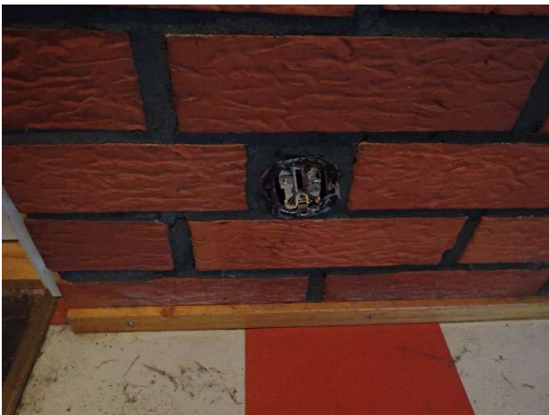
kuva 23. vaurioitunut pistorasia
