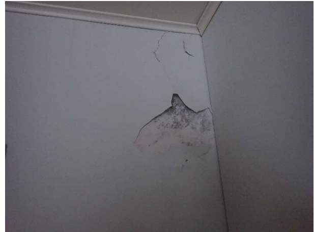
kuva 20. väliseinän kosteusjälkiä
