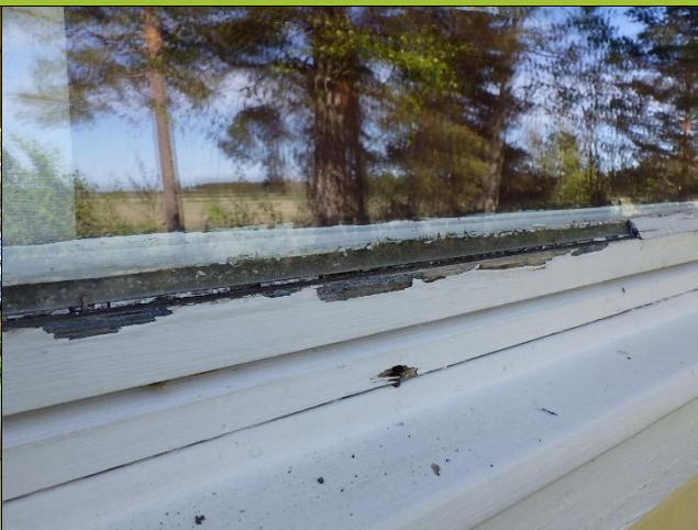
Kuva 16. Ikkunoiden puuosat huoltomaalauksen tarpeessa.
