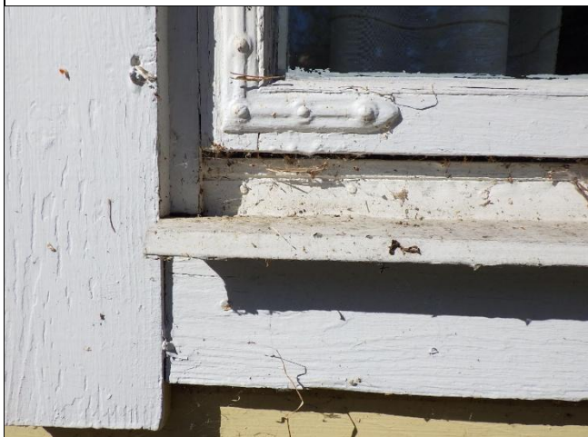
Kuva 17. Vesipellitykset melko vaatimattomat.
