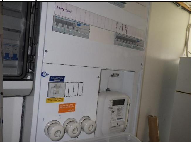
Kuva 40. Sähköpääkeskusta.
