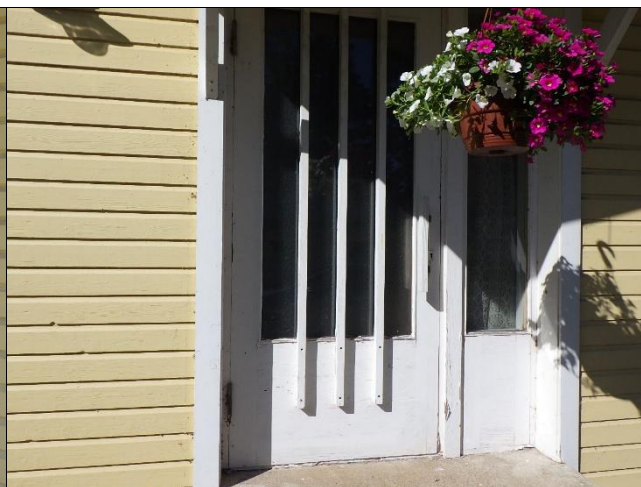
Kuva 20. Laajennetun osan ulko-ovi vanhahko 2-lehtinen ulko-ovi.
