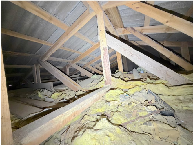
Kuva 6. Vesikaton kantavien rakenteiden kunto on hyvä.
