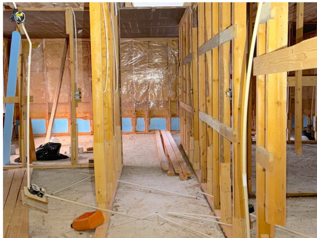
Kuva 10. sisälattiat ja sisäseinät on purettu.
