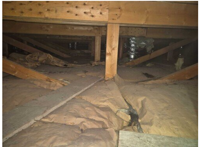
Kuva 38 Kuva tasakaton ja yläpohjarakenteen välistä, jossa on reilun kokoinen tuulettuva ilmatila.
