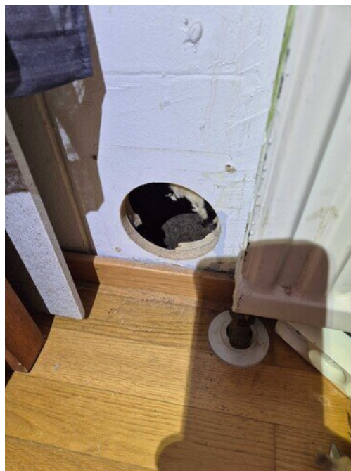
Kuva 16 Rakenneavauksen kohta vuodelta 2009
