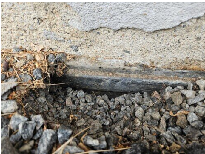
Kuva 12 Sokkelin kosteudeneristyksen tarkastusta
