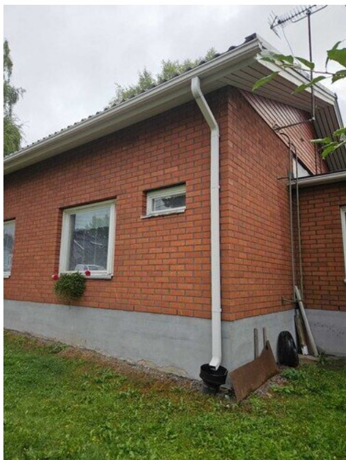
Kuva 6 Sadevesijärjestelmien tarkastusta
