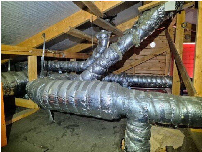
Kuva 40 Ilmanvaihto ja tuuletusputkien kondenssisuojaeristeen tarkastusta.
