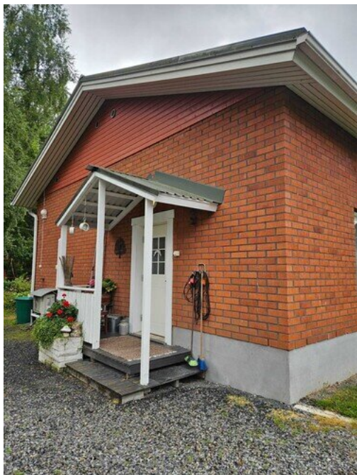
Kuva 25 Julkisivua täydentävien rakenteiden tarkastusta
