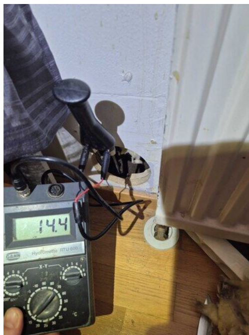
Kuva 18 Puun painokosteuden mittaaminen rakenteesta. Tarkastushetken aikana rakenteesta ei todettu kosteuspoikkeamaa.
