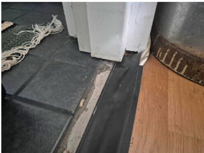
Kuva 45 Silmämääräisen tarkastuksen perusteella väliseinän alaohjauspuu vaikutti kuitenkin olevan lattiapintojen tasossa
