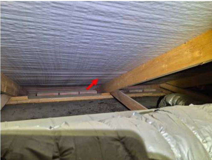
Kuva 37 Ullakkotilan todettiin tuulettuvan räystäiden suunnasta
