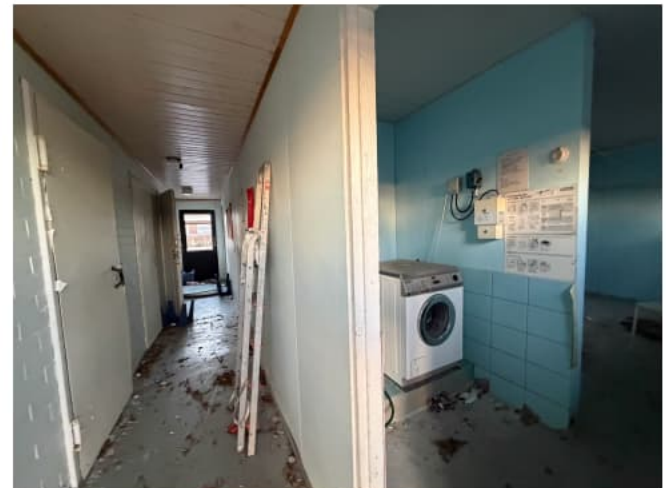
Kuva 53 B-talon käytävä yhteiskäyttötiloille
