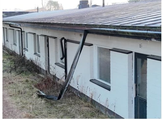
Kuva 5. Läpivienneissä ei havaittu huomautettavaa. Kuva 6. Rännien uusiminen on ajankohtaista
