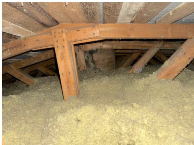
Kuva 9. Vesikaton kantavien rakenteiden kunto on hyvä.
