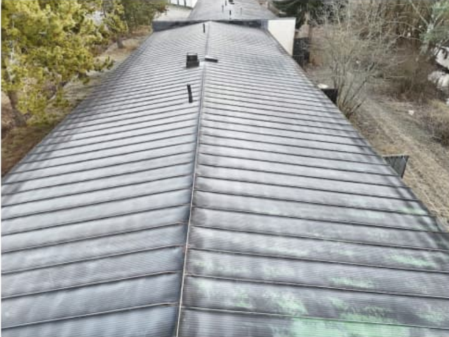
Kuvat 3. Taloissa on konesaumattu peltikatto
