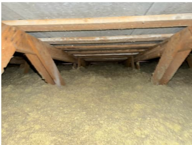
Kuva 10. Haitallista kondenssia ei havaittu
