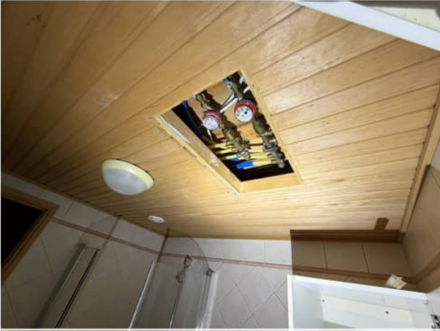
Kuva 20. A-talossa muovi sekä komposiittiputkisto
