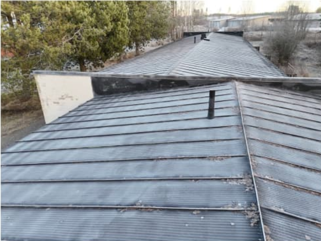
Kuva 5. Läpivienneissä ei havaittu huomautettavaa. Kuva 6. Rännien uusiminen on ajankohtaista
