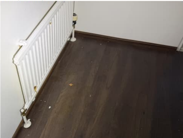
Kuva 22. Lämpöpatterit jäätyneet
