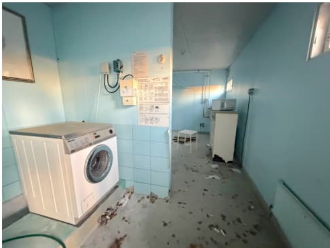
Kuva 52 Pesutupa ja kuivaushuone
