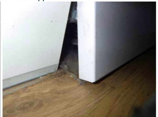
8. Astianpesukoneen alapuolelle on valumasuojakaukalo
