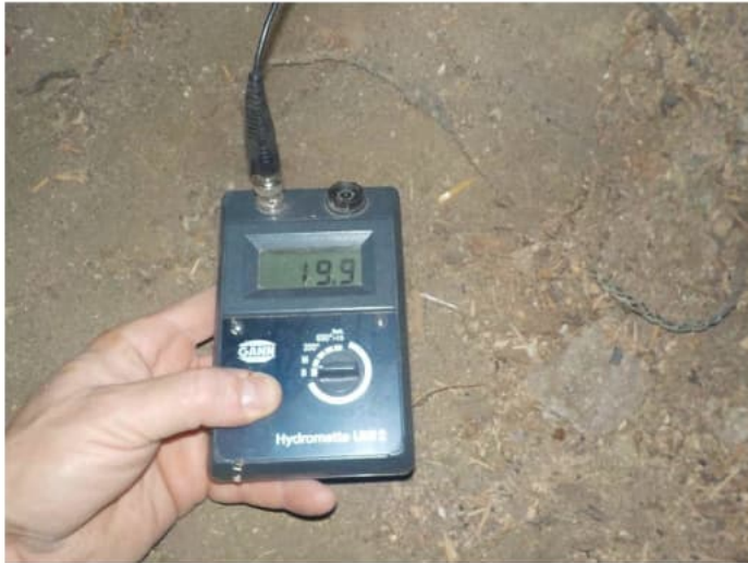
Lattiarakenteen aluslaudan kosteuden mittaus.
