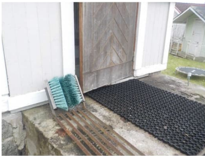
Kuistin betoniportaiden tasanne.
