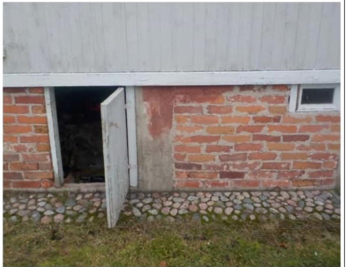
Kuistin tiilimuurattua sokkeliä.
