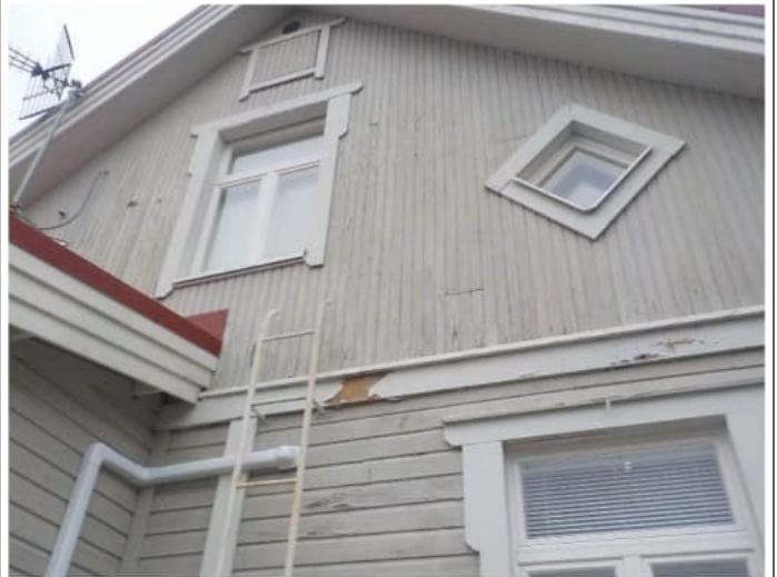
Julkisivuverhouksen säärasitusta.
