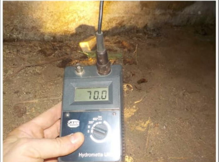
Lattiarakenteen villaeristeiden suhteellisen kosteuden mittaus.
