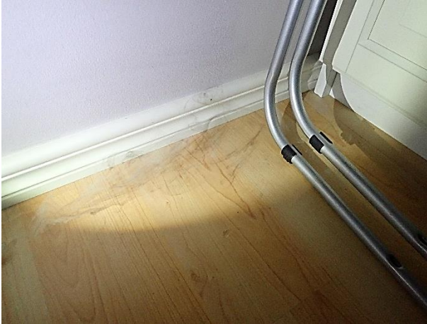
Alakerran lattian ja seinän rajasta tulee vuotoilmaa rakenteista sisäilmaan.
