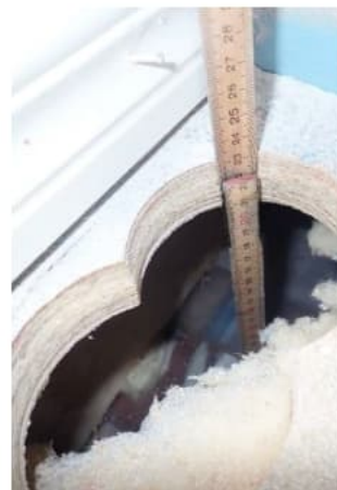
Kondenssia tapahtuu myös uusissa hirsirakennuksissa, jos seinän ja yläpohjan liitoksessa on ilmavuoto. ( konvektiovirtaus )
