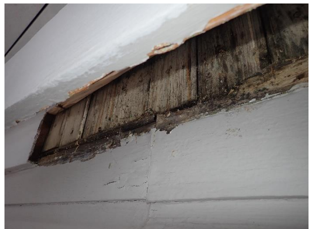
Tippalautoja avattiin keittiön kohdalta seinän yläreunasta, ikkunan korosta ja seinän alareunasta. Yläreunassa ei ollut havaittavissa viitteitä kosteuden aiheuttamista vaurioista. Räystäsrakenne suojaa seinän yläosaa.
