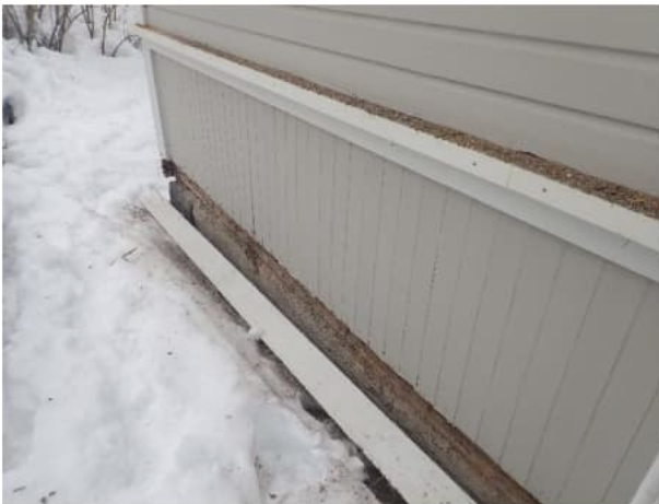
Kadunpuolen seinärakenteessa ei havaittu alempana merkkejä lahovaurioista.
