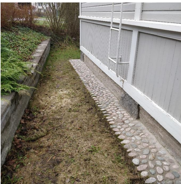
Kivetys ohjaa pintavesiä pois rakennuksen juuresta.
