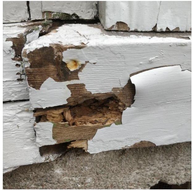
Sokkelin ja lautaverhouksen väliseen tippalautaan kohdistuu kosteusrasitusta. Tippalaudassa on paikoitellen lahovaurioita.
