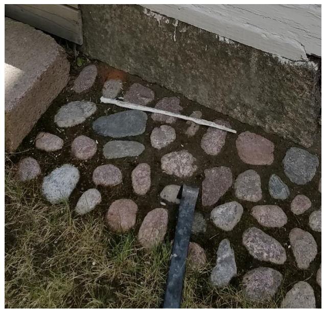
Sokkelin juureen on tehty kivetytys, jonka kallistus on rakennuksesta poispäin.
