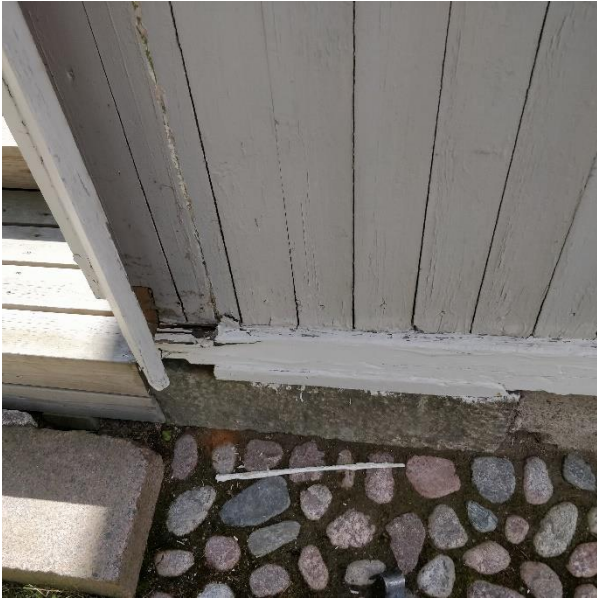
Sokkelin ja lautaverhouksen väliseen tippalautaan kohdistuu kosteusrasitusta. Tippalaudassa on paikoitellen lahovaurioita.
