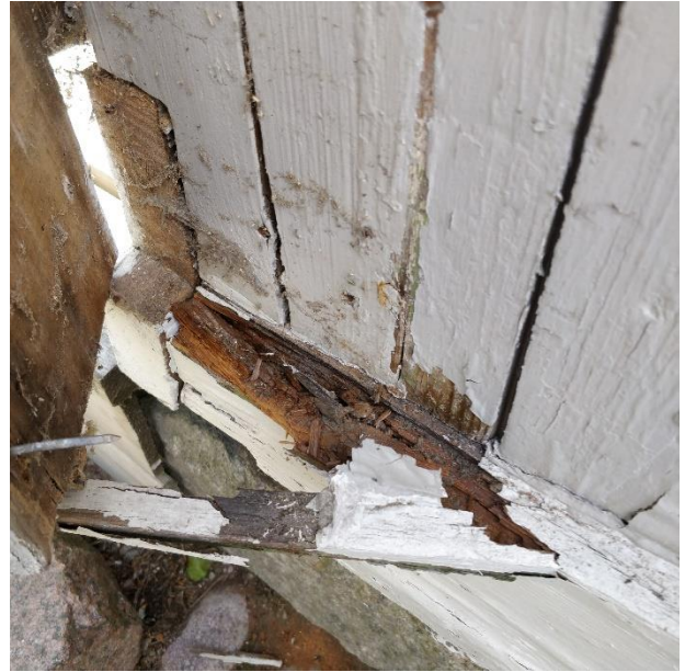
Sokkelin ja lautaverhouksen väliseen tippalautaan kohdistuu kosteusrasitusta. Tippalaudassa on paikoitellen lahovaurioita.
