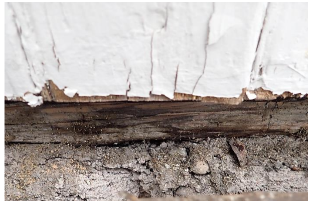
Seinän alaosassa on riski seinärakenteen vaurioitumiselle, koska seinäpintaa pitkin valuva vesi voi päästä seinän alaosassa olevan vuorilaudan taakse (ks. valokuvat), sokkelin päälle ja kastella seinän alaosaa. Pihan puolella alapuussa oli vähäisiä kosteusjälkiä (oikea kuva), mutta ei lahovaurioita.
