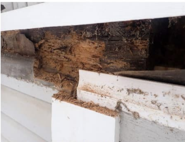
Tippalaudan taustalla olevassa hirressä oli kuivalahoa. Laho oli syvällä hirsirakenteessa ja voi vaikuttaa ulkoseinärakenteen kantavuuteen.
