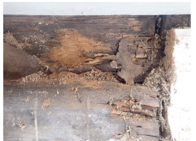
Tippalaudan taustalla olevassa hirressä oli kuivalahoa. Laho oli syvällä hirsirakenteessa ja voi vaikuttaa ulkoseinärakenteen kantavuuteen.
