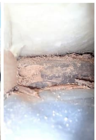
Kondenssia tapahtuu myös uusissa hirsirakennuksissa, jos seinän ja yläpohjan liitoksessa on ilmavuoto. ( konvektiovirtaus )
