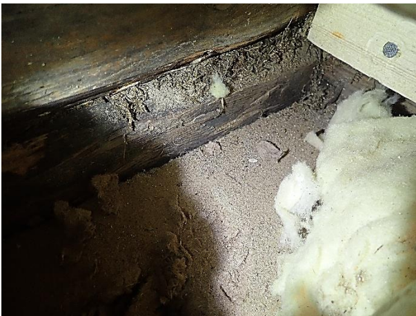
Alakerran makuuhuoneen lattian ulkonurkan rakenneavauskohdassa (ks. pohjakuva) oli havaittavissa hirren sisäpinta. Hirsien välin tilkitsemisessä on käytetty luonnonmateriaalia. Tilkitsemisessä käytetty luonnonmateriaali on mikrobivaurioitunut.
