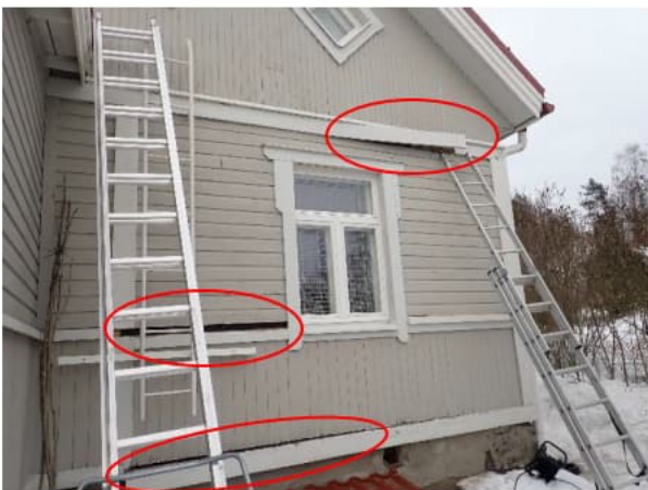
Pihan puoleisen seinän tippalaudoituksia avattiin kolmesta kohdasta. Ylimmän tippalaudan taustalla oli havaittavissa lahovaurioita.
