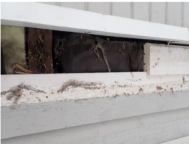
Pesuhuoneen kohdalla villaeriste oli paneelin taustalla osittain paljaana. Mineraalivilla on alttiina ulkoilman vaikutuksille.
