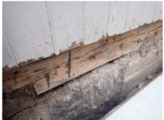
Kadunpuolen seinärakenteessa ei havaittu alempana merkkejä lahovaurioista.
