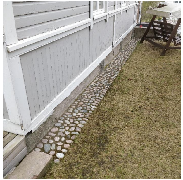
Sokkelin juureen on tehty kivetytys, jonka kallistus on rakennuksesta poispäin.
