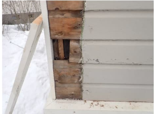
Kadunpuolen seinärakenteessa ei havaittu alempana merkkejä lahovaurioista.
