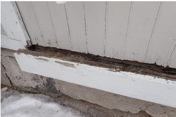
Seinän alaosassa on riski seinärakenteen vaurioitumiselle, koska seinäpintaa pitkin valuva vesi voi päästä seinän alaosassa olevan vuorilaudan taakse (ks. valokuvat), sokkelin päälle ja kastella seinän alaosaa. Pihan puolella alapuussa oli vähäisiä kosteusjälkiä (oikea kuva), mutta ei lahovaurioita.
