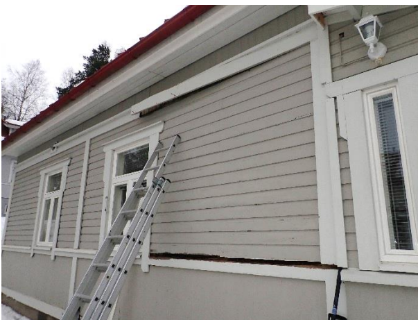
Tippalautoja avattiin keittiön kohdalta seinän yläreunasta, ikkunan korosta ja seinän alareunasta. Yläreunassa ei ollut havaittavissa viitteitä kosteuden aiheuttamista vaurioista. Räystäsrakenne suojaa seinän yläosaa.
