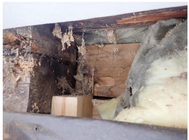
Pesuhuoneen kohdalla villaeriste oli paneelin taustalla osittain paljaana. Mineraalivilla on alttiina ulkoilman vaikutuksille.
