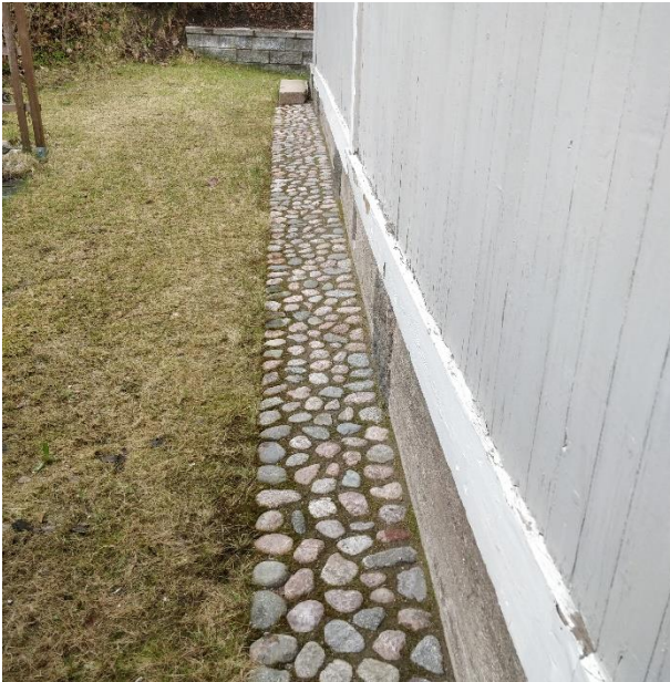
Sokkelin juureen on tehty kivetytys, jonka kallistus on rakennuksesta poispäin.
