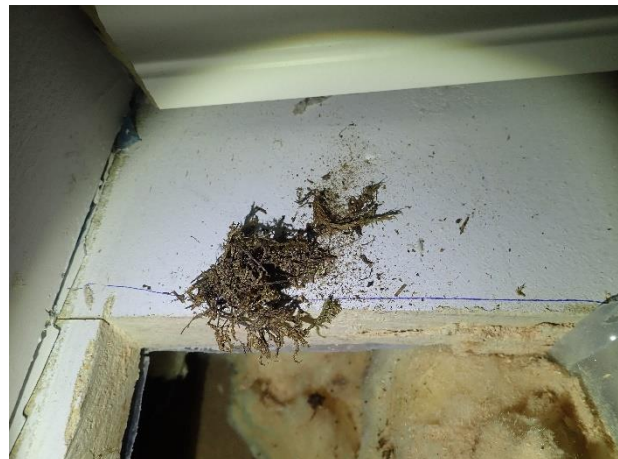
Alakerran makuuhuoneen lattian ulkonurkan rakenneavauskohdassa (ks. pohjakuva) oli havaittavissa hirren sisäpinta. Hirsien välin tilkitsemisessä on käytetty luonnonmateriaalia. Tilkitsemisessä käytetty luonnonmateriaali on mikrobivaurioitunut.
