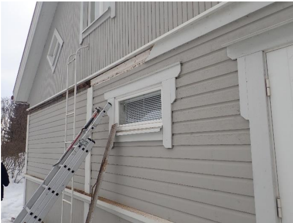
Tippalautoitus avattiin pesuhuoneen ikkunan kohdalta.
