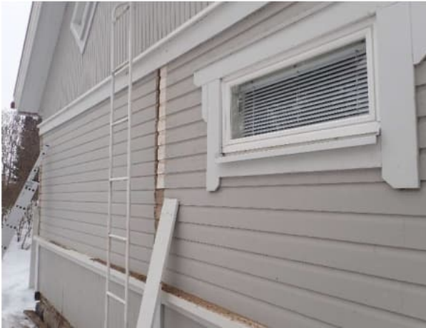
Kadunpuolen seinärakenteessa ei havaittu alempana merkkejä lahovaurioista.
