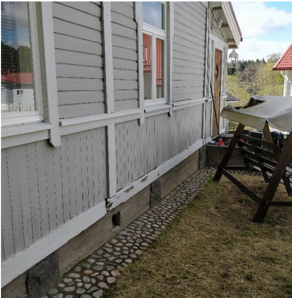
Sokkelin ja lautaverhouksen väliseen tippalautaan kohdistuu kosteusrasitusta. Tippalaudassa on paikoitellen lahovaurioita.
