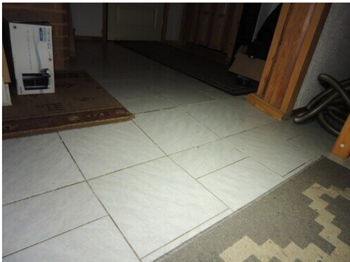
Kuva 43 Lattiassa korkeuseroa/epätasaisuutta
