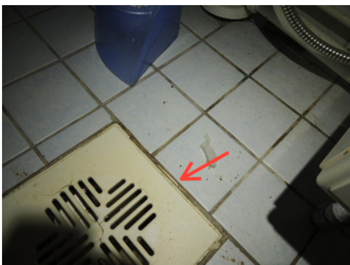
Kuva 51 Laattasaumoissa ikääntymistä ja halkeilua
