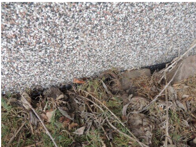
Kuva 11 Patolevyn yläreunasta puutuu reunalista
