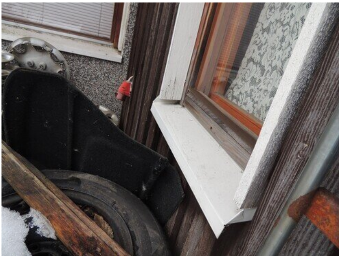
Kuva 28 Alakuistin vesipelleissä kallistus niukka
