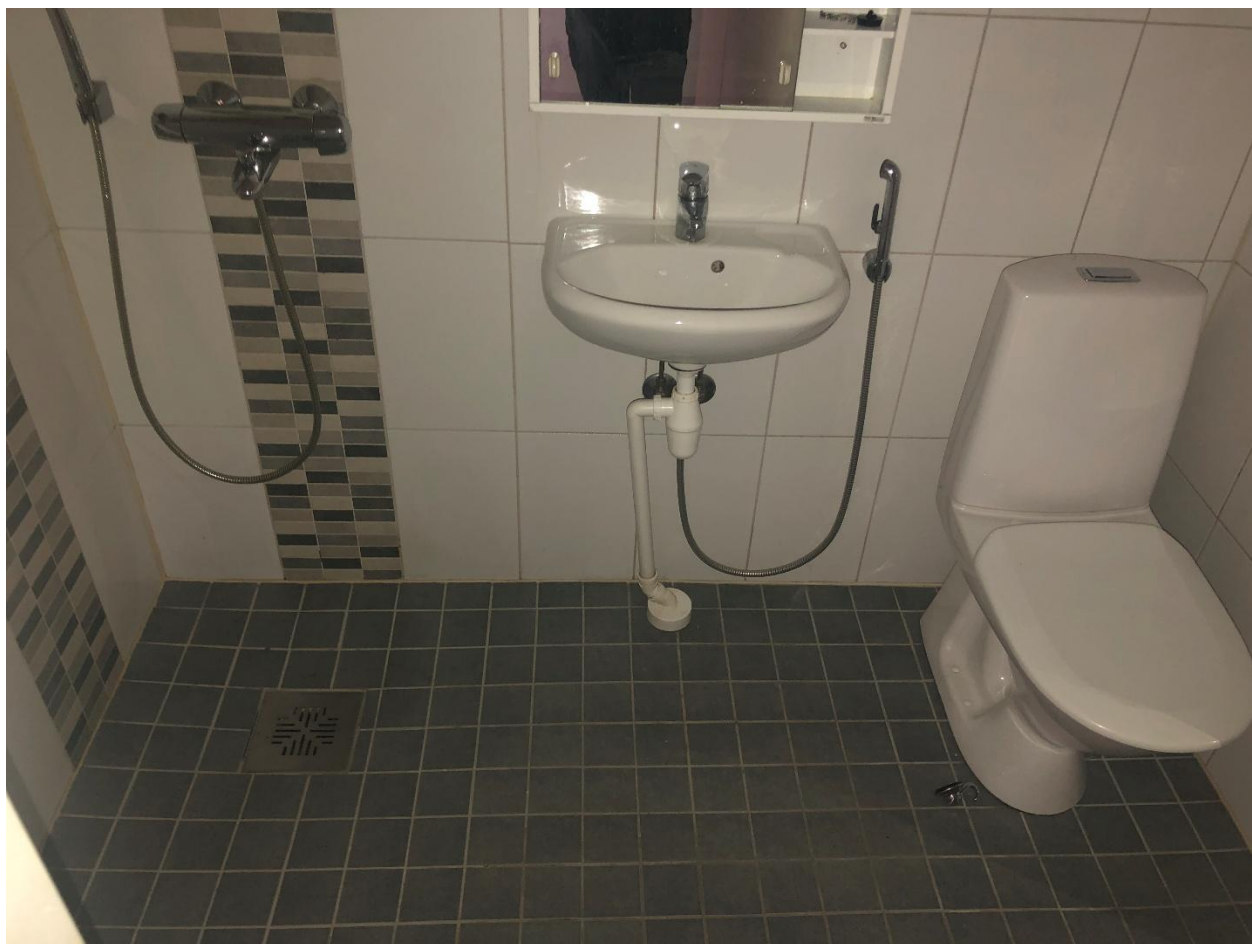
Badrum/wc, utrymmet har renoverats 2014
