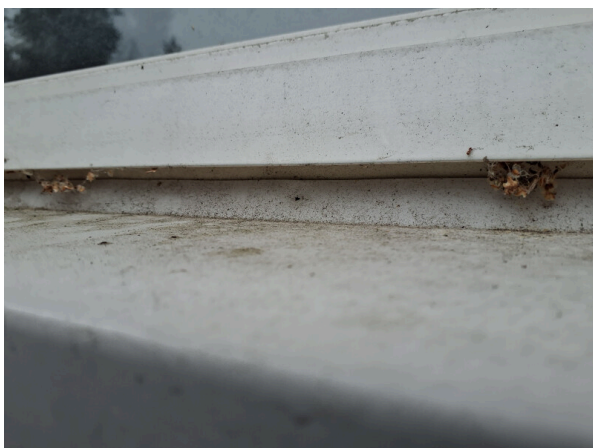
21. Vesipellit samassa urassa kuin vedenpoistoreiät
