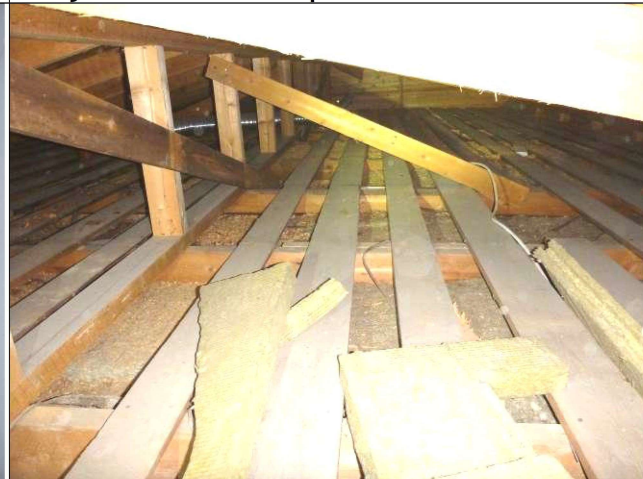
Kuva 22 Vanhemman osan yläpohjatilalla
