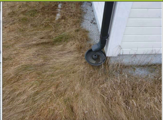
Kuva 5. Kattovesipoisto
