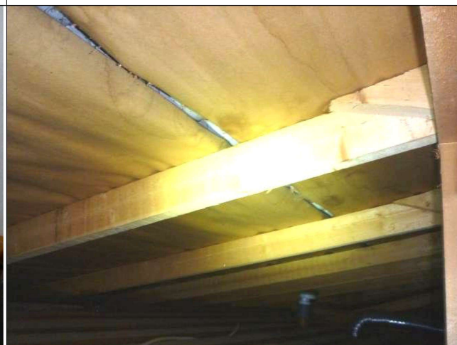
Kuva 24 Vanhemman osan aluskate rakoilee
