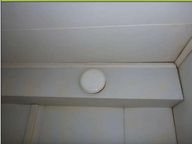
Kuva 45 Poistovennttiili
