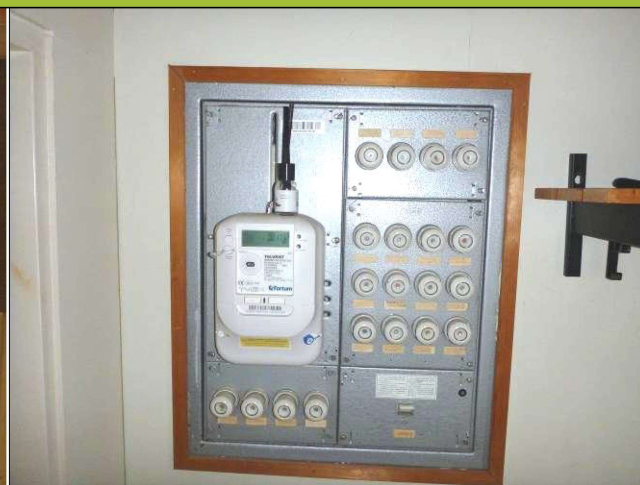
Kuva 48 Pääkeskus mittarilla
