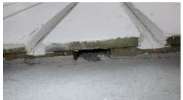
14. Julkisivuverhouksen taustan tuuletusrako
