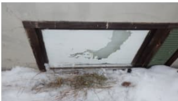
7. Ikkuna maanpinnan tasolla
