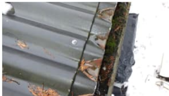
18. Pinnoitteen irtoilua ja ruostetta peltien reunoissa
