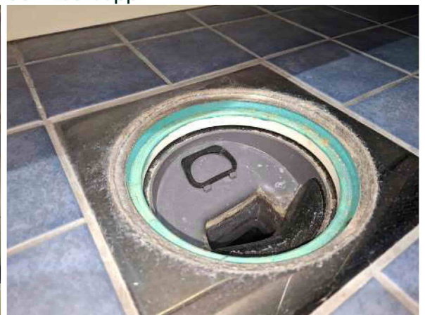
38. Yläkerran WC:n lattiakaivo
