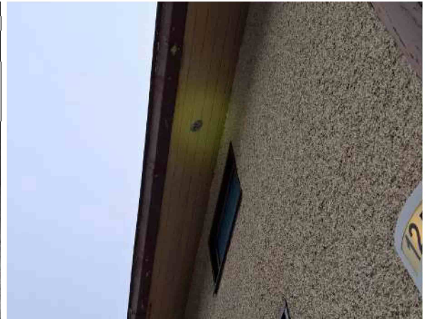
28. Räystään tuuletusritilä
