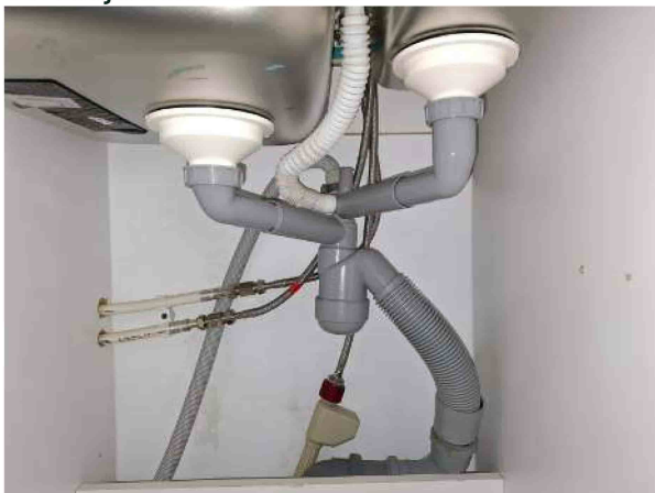
41. Laajennusosan keittiön allaskaappi
