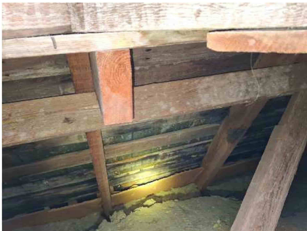
23. Yläpohjatilán vino-osan tuuletusrako
