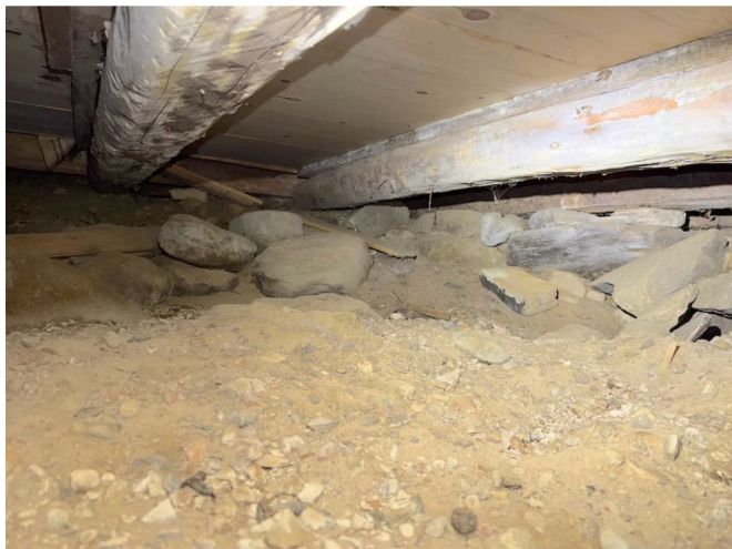
Kuva 11. Alapohjan rakenteissa ei havaittu merkittäviä vaurioita
