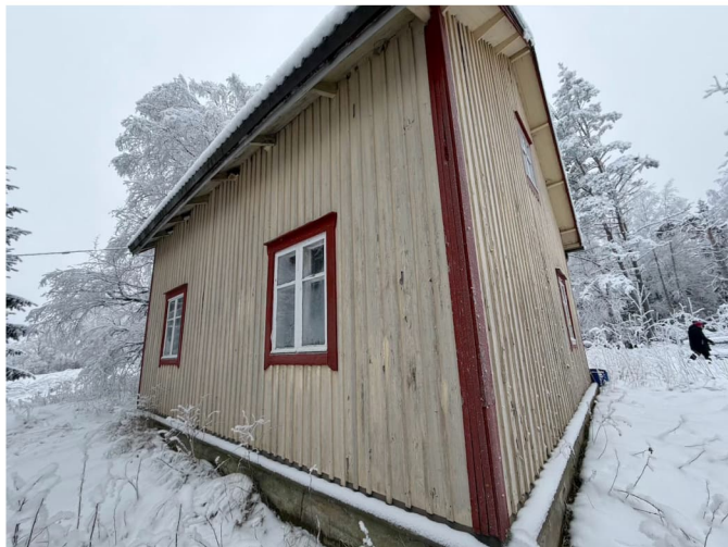
Kuva 10. Sokkelin levennys lisää kostumisen riskiä seinien alaosalle
