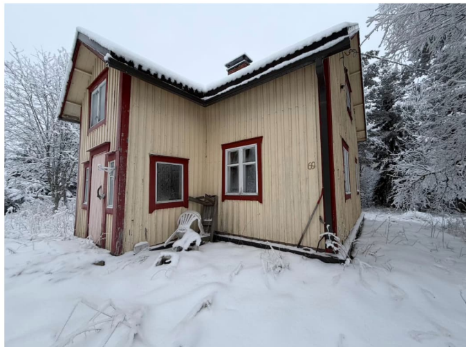
Kuva 9. Pystypaneeliverhoukset, ikkunat ja ovet, ovat heikossa tai tyydyttävässä kunnossa
