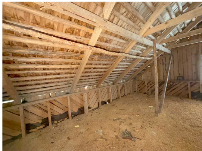
Kuva 8. Alkuperäinen pärekatto jätetty peltikaton alle.
