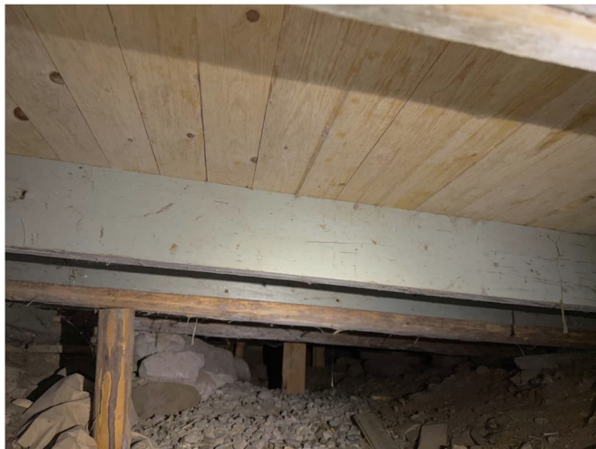
Kuva 12. Lankkulattian kunto on hyvä
