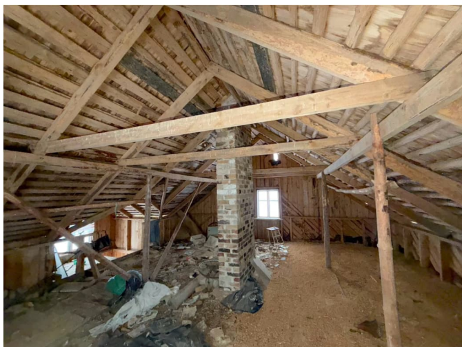
Kuva 7. Vesikaton kantavien rakenteiden kunto on hyvä.
