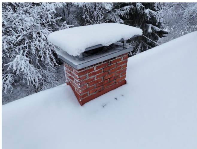
Kuva 6. Savupiipun kylmässä osassa ei merkittävää pakkasrapautumaa
