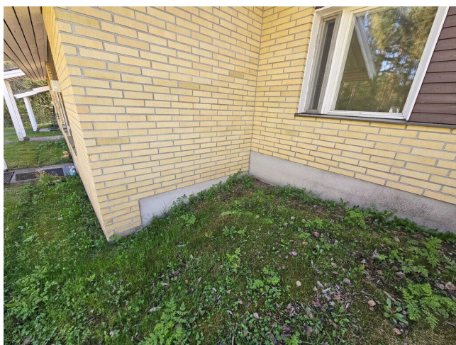
Kuva 18 Yleiskuva sokkelin "hammastuksesta"
