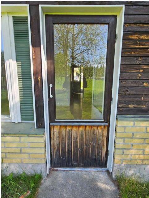
Kuva 22 Maalipinta kulunut.
