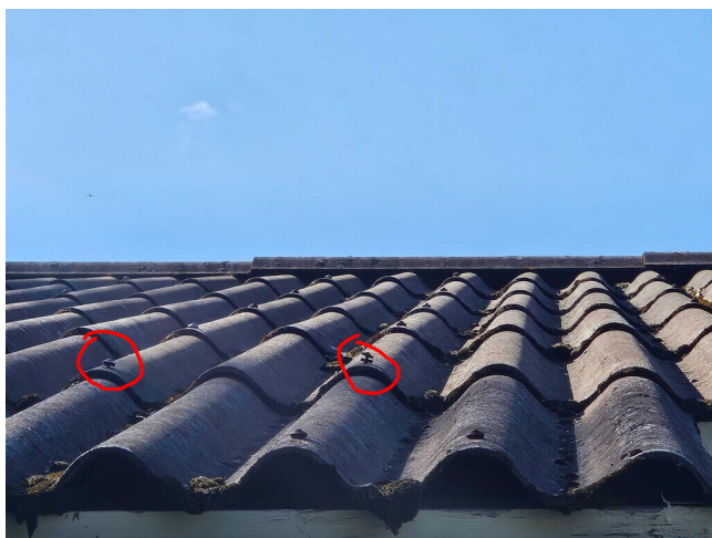
Kuva 25 Kohollaan olevia naulauksia
