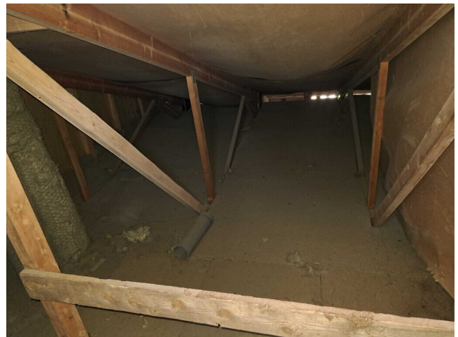
Kuva 30 Yleiskuva yläpohjasta, tuuletus räystäältä
