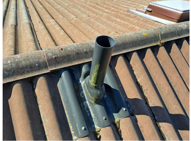
Kuva 28 Viemärintuuletus oikeaoppisesti lähellä harjaa
