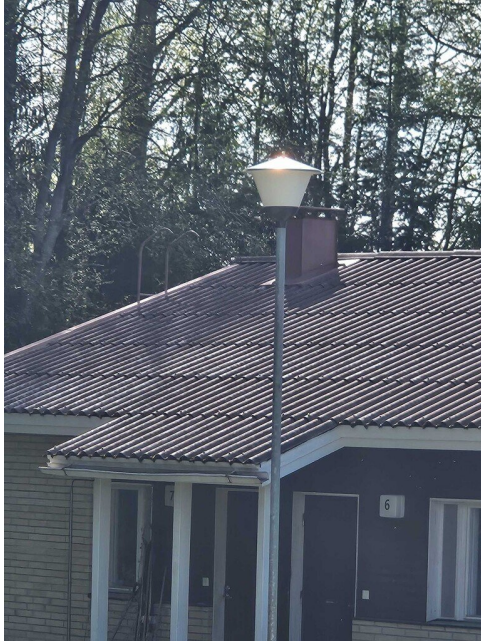
Kuva 57 Pylväsvalot uusittu joskus
