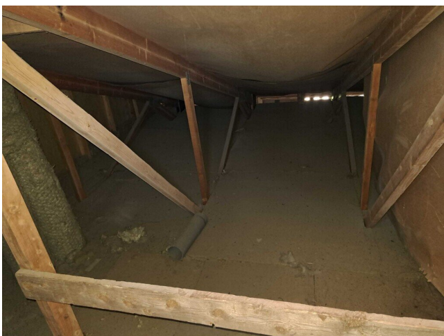
Kuva 54 Viemäriputki eristetty yläpohjassa.
