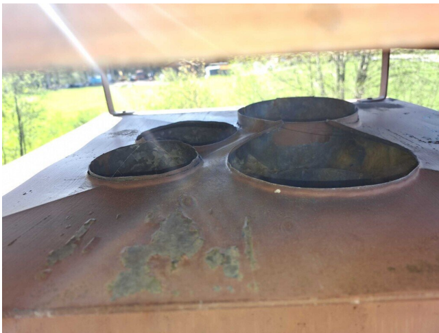
Kuva 50 Asunnon ilmanvaihtoputkien päät vesikatolla.
