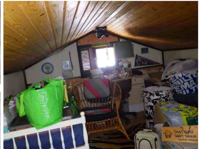
25. Yläpohjan vinoa osaa
