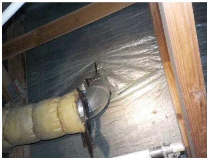
Poistoilmakanavan vesikaton läpivienti.
