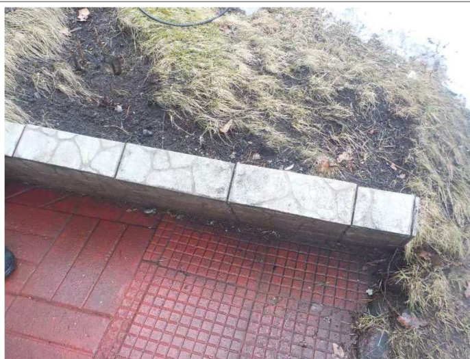
Rakennuksen ulkopuolisen ns. maanvastaisen muurin kaltevuutta.
