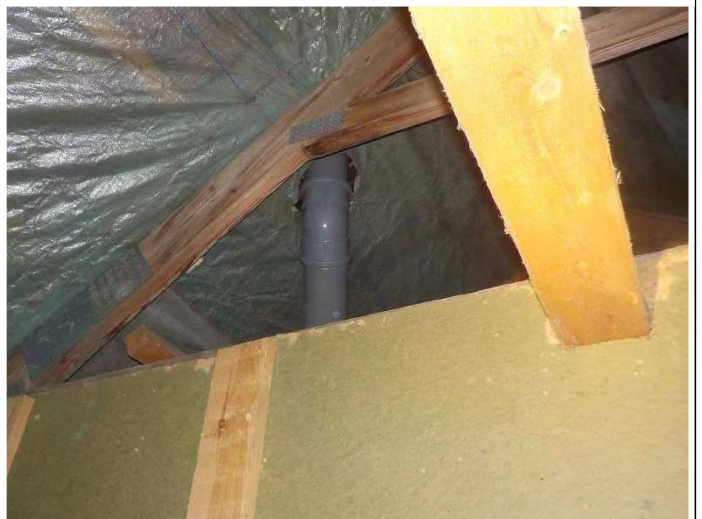
Viemärin tuuletusputki.
