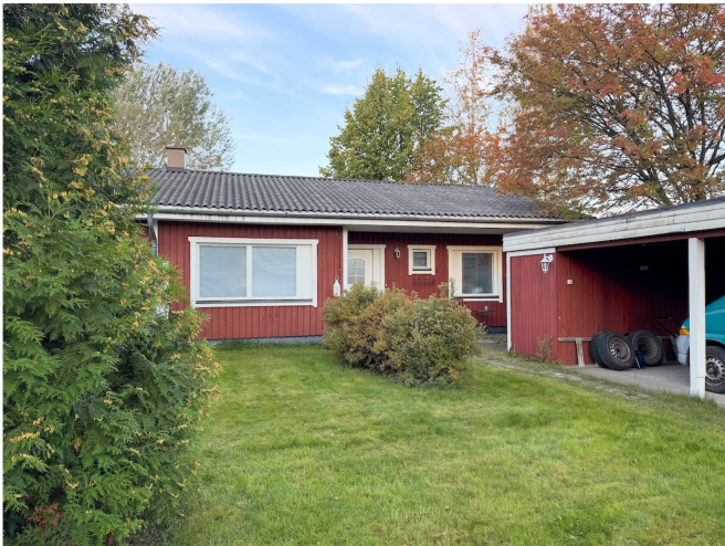
Kuva 8. Ulkoverhouksen kunto on hyvä, samoin ikkunoiden ja ovien.
