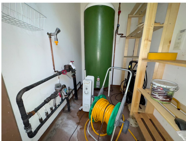
Kuva 13. Alkuperäinen lämminvesivaraaja
