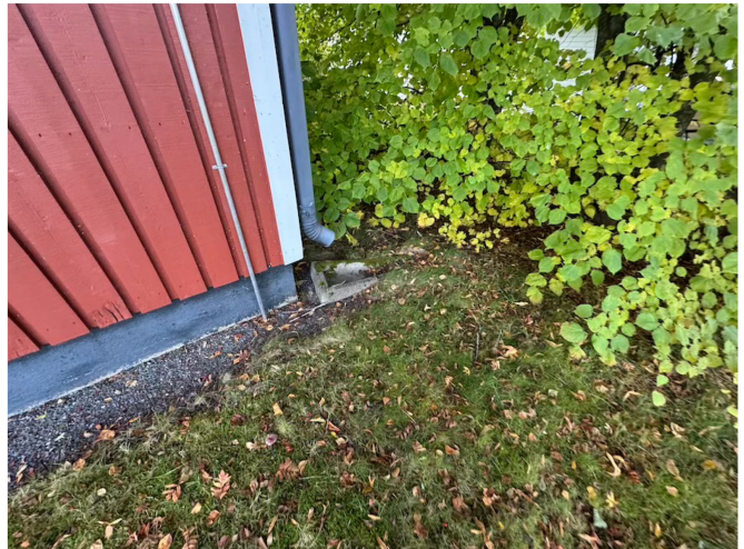
Kuva 9. Takapihan puolella veden poisto tapahtuu avokourun avulla.
