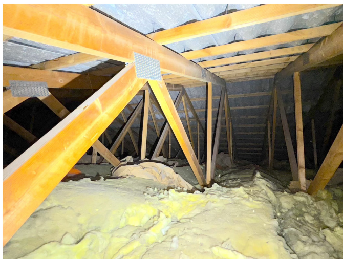
Kuva 6. Kuva yläpohjasta. Vesikaton kantavien rakenteiden kunto on hyvä.
