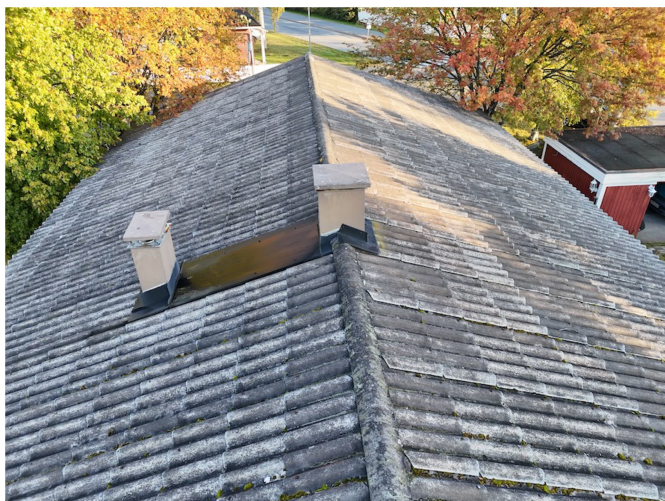
Kuva 4. Varttikatossa ei havaittu halkeamia tai rikkoutumaa
