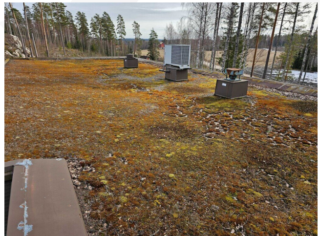
Kuva 71 Yleiskuva desinfioitikeskuksen katosta.
