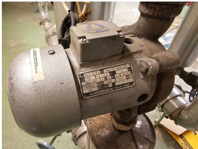
Kuva 97 Lämmitysjärjestelmän pumppu.
