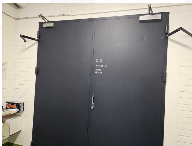
Kuva 52 Varastojen väliovissa ei havaittu puutteita.
