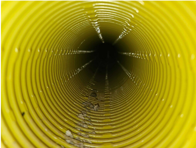
Kuva 88 Salaojaputki sisältä.
