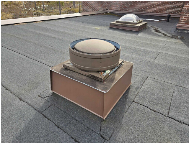
Kuva 107 Alkuperäinen huippuimuri varastorakennuksessa.
