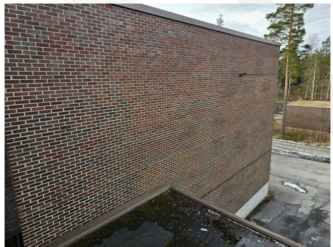
Kuva 34 Yleiskuva varastorakennuksen julkisivusta.
