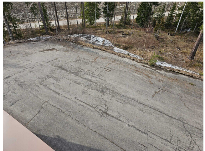
Kuva 2 Yleiskuva varastorakennuksen asfaltoidulta piha-alueelta.
