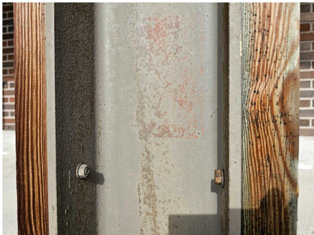
Kuva 6 Lastauslaiturin katoksen teräsosia.
