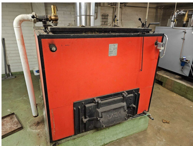
Kuva 94 Alkuperäinen lämmityskattila.
