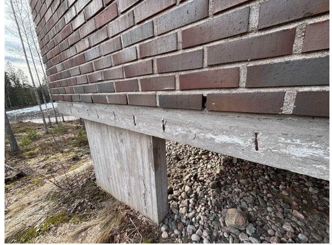
Kuva 28 Desinfiointikeskuksen alapohja- ja palkkirakenteita.
