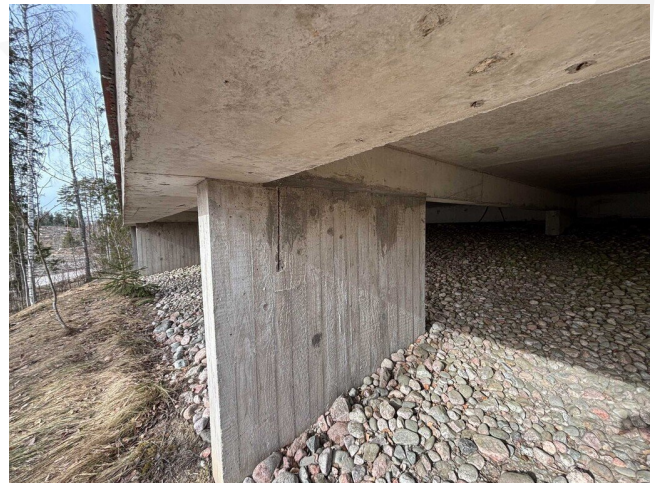
Kuva 30 Desinfiointikeskuksen alapohja- ja palkkirakenteita.
