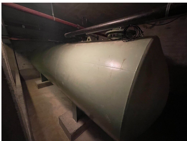
Kuva 98 Alkuperäinen käytössä oleva öljykattila.
