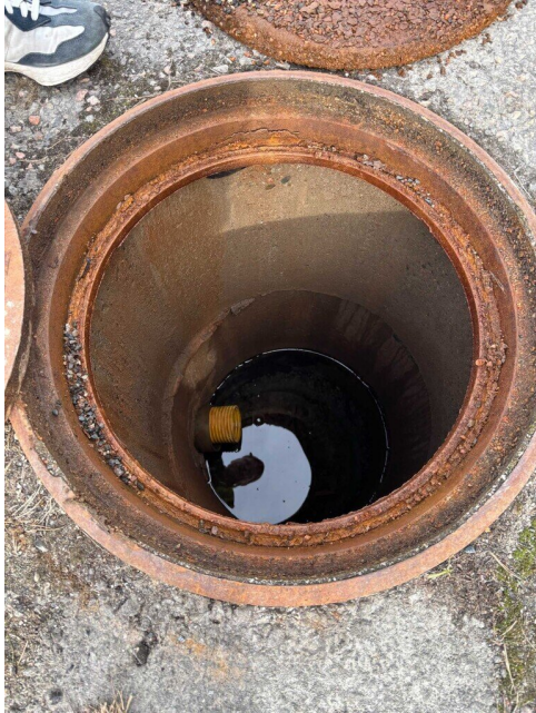
Kuva 92 Salaojakaivo rakennuksen ulkopuolella.
