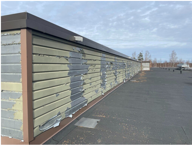
Kuva 43 Varasto: vesikaton / IV-korotusten julkisivupellityksiä.
