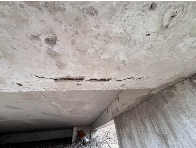
Kuva 29 Desinfiointikeskuksen alapohja- ja palkkirakenteita.
