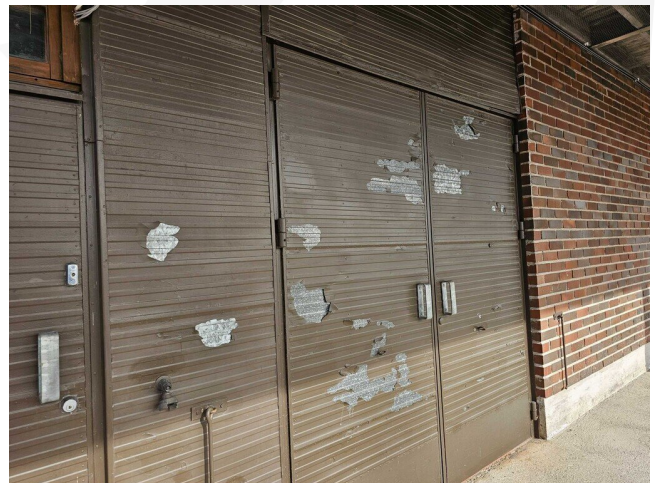
Kuva 56 Varastorakennuksen teräsovi ulkoa.
