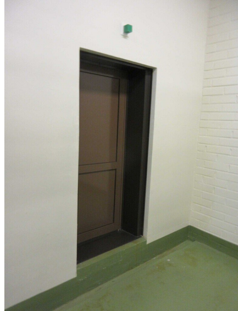
Kuva 58 Varastorakennuksen hätäpoistumisteiden ovet on uusittu.
