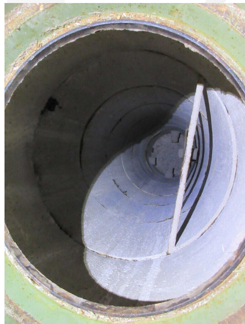
Kuva 91 Salaojakaivo rakennuksen sisäpuolella.
