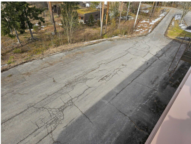
Kuva 1 Yleiskuva varastorakennuksen asfaltoidulta piha-alueelta.
