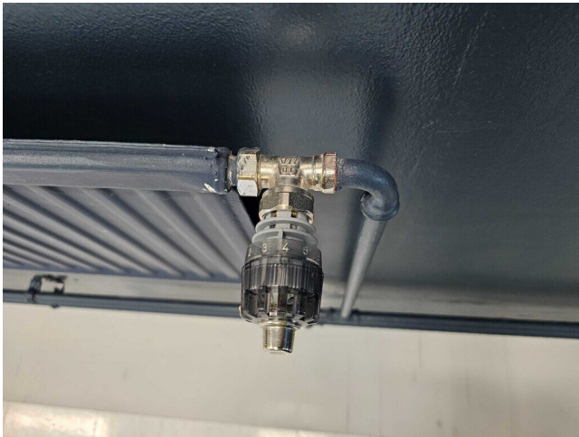
Kuva 100 Alkuperäinen lämpöpatterin termostaatti varastorakennuksen toimistossa.
