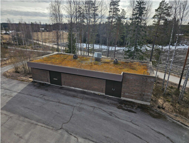
Kuva 3 Yleiskuva varastorakennuksen asfaltoidulta piha-alueelta.
