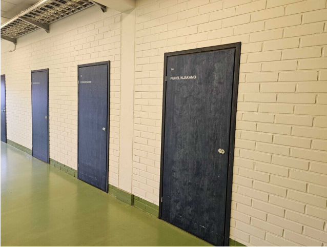
Kuva 53 Varastorakennuksen väliovissa ei havaittu puutteita.
