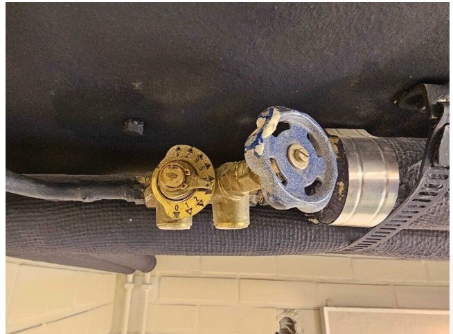
Kuva 101 Lämpöverkon linjasäätöventtiili.
