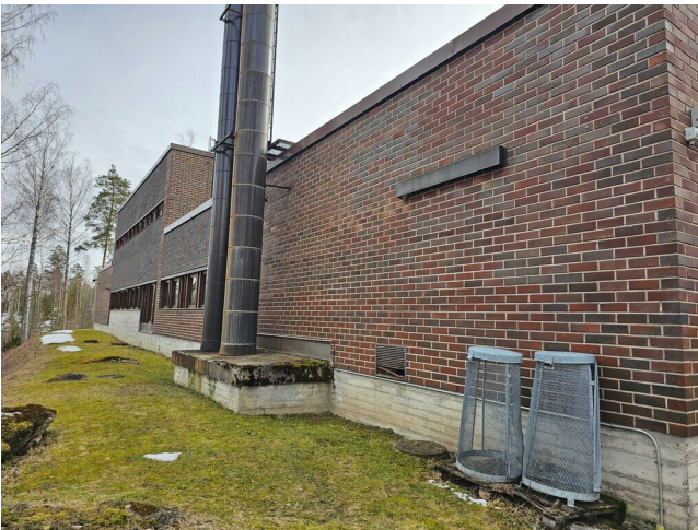
Kuva 31 Yleiskuva varastorakennuksen julkisivusta.
