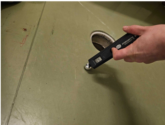
Kuva 15 Alapohjan pintakosteuksia mitattiin pistokokein.
