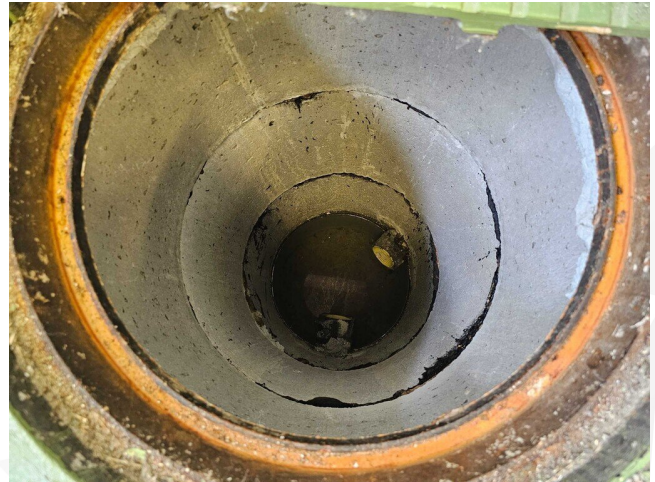
Kuva 89 Salaojakaivo rakennuksen sisäpuolella.
