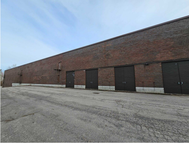
Kuva 57 Varastorakennuksen teräsovia ulkoa.
