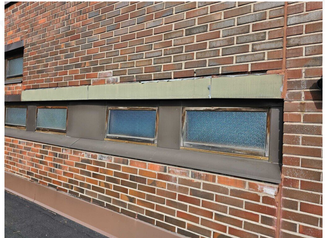
Kuva 38 Varasto: 3.kerroksen desinfiointikeskuksen puoleinen aukon ylityspalkki.
