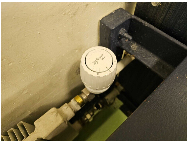
Kuva 102 Uusittu patterin termostaatti varastorakennuksessa.
