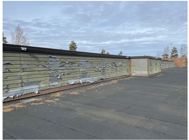
Kuva 44 Varasto: vesikaton / IV-korotusten julkisivupellityksiä.
