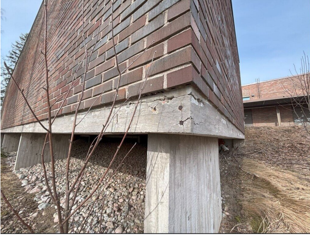
Kuva 27 Desinfiointikeskuksen alapohja- ja palkkirakenteita.
