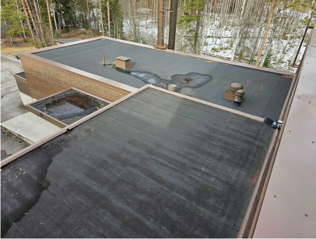
Kuva 64 Yleiskuva varastorakennuksen vesikatosta.
