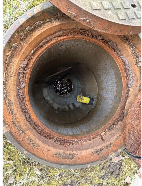
Kuva 93 Salaojakaivo rakennuksen ulkopuolella.
