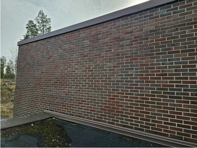
Kuva 35 Julkisivuissa kasvoi pienissä määrin jäkälää.
