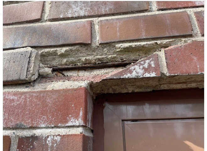
Kuva 42 Varasto: hätäuloskäynnin aukonylityspalkin vaurioita.
