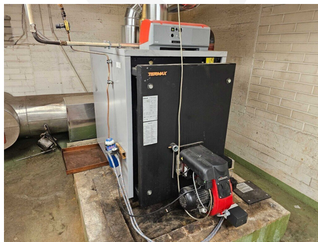
Kuva 95 Uusittu lämmityskattila.
