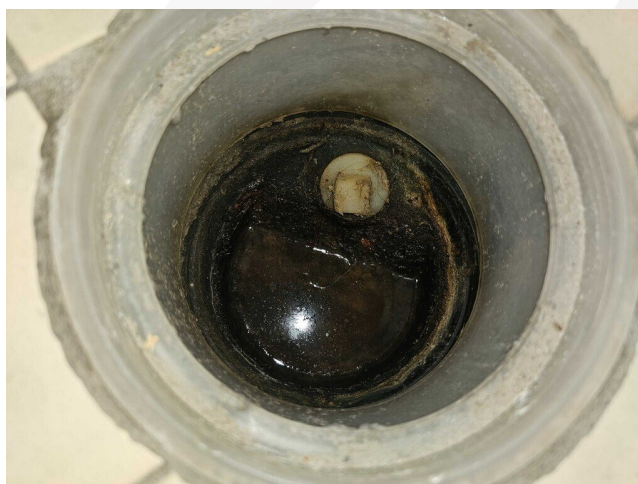
Kuva 112 Alkuperäinen lattiakaivo varastorakennuksen pesutilassa.
