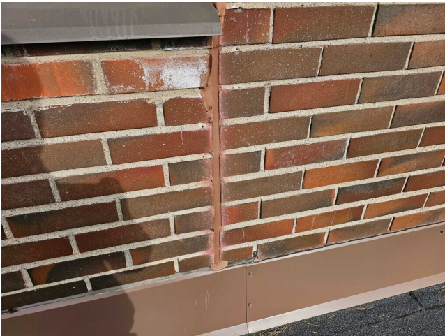
Kuva 37 Varasto: julkisivun elastinen liikuntasäula.
