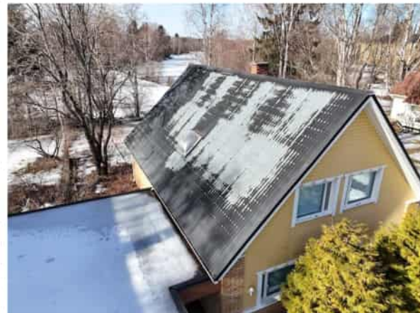
Profiilipeltikatto, vesikate on osittain kulunut: toinen lappeista on selvästi pinnoituksesta kulunut
