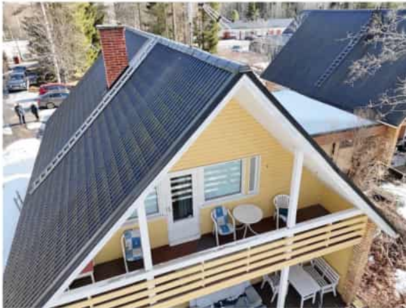
Profiilipeltikatto, vesikate on osittain kulunut: toinen lappeista on selvästi pinnoituksesta kulunut
