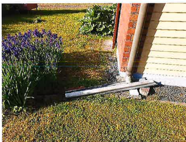
Rakennuksen ulkopuolista kosteudenhallintaa, sadevedet laskevat maaperään rakennuksen viereen, joka lisää kosteusrasitusta perustuksille ja sitä kautta ulkoseinien alajuoksuille
