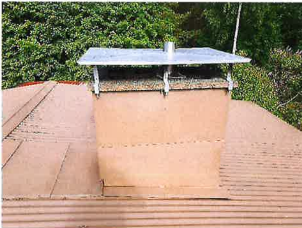
Vesikatolla tehdyt havainnot viittaavat sisäteräspiipun jälkiasennukseen öljykattilan palokaasujen hormissa.
