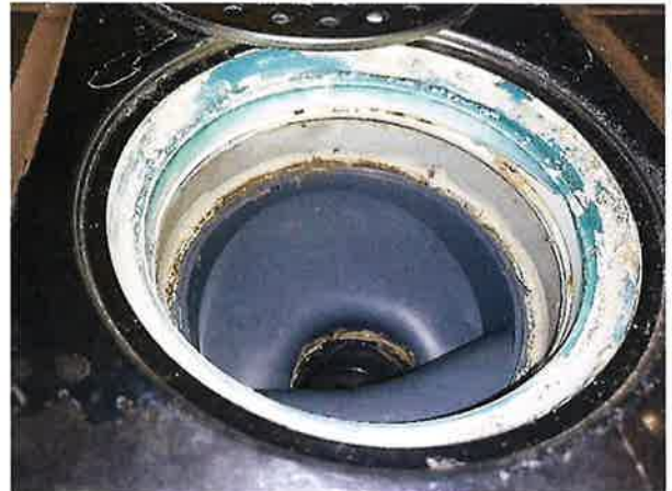
Pesuhuoneen ja saunan lattiakaivot on uusittu saneerauksen yhteydessä.
