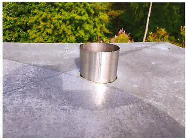
Vesikatolla tehdyt havainnot viittaavat sisäteräspiipun jälkiasennukseen öljykattilan palokaasujen hormissa.
