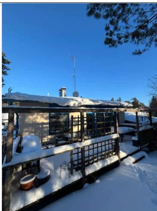
Kuva 26 Terassin rakenteissa ei havaittu poikkeamia.
