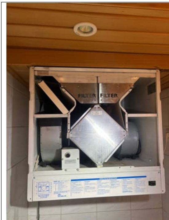
Kuva 77 Koneellinen tulopoisto lämmön talteenotolla. Lämmön talteenotto koneessa toimii vasta-virta kennolla. Tarkastuksessa kone avattiin, koneessa ei havaittu poikkeamia.
