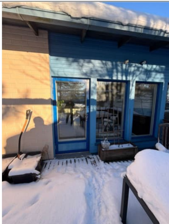
Kuva 20 Olohuoneessa havaittiin kiinteälasisia ikkunoita. Ikkunoiden kunnossa ei havaittu poikkeamia.
