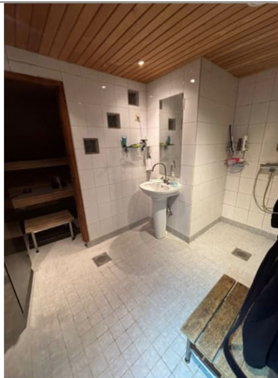
Kuva 27 Pesuhuoneessa lattia ja seinät on laatoitettu, ja katossa on panelointi. Pesuhuone on alkuperäiskunnossa ja se on rakennettu vuonna 2007.
