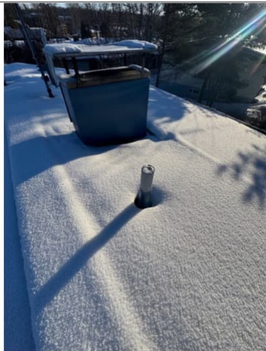
Kuva 7 Piipun läpiviennissä ei havaittu poikkeamia. Viemärin tuuletusputki oli tuotu eristämättömänä vesikatteen läpi.
