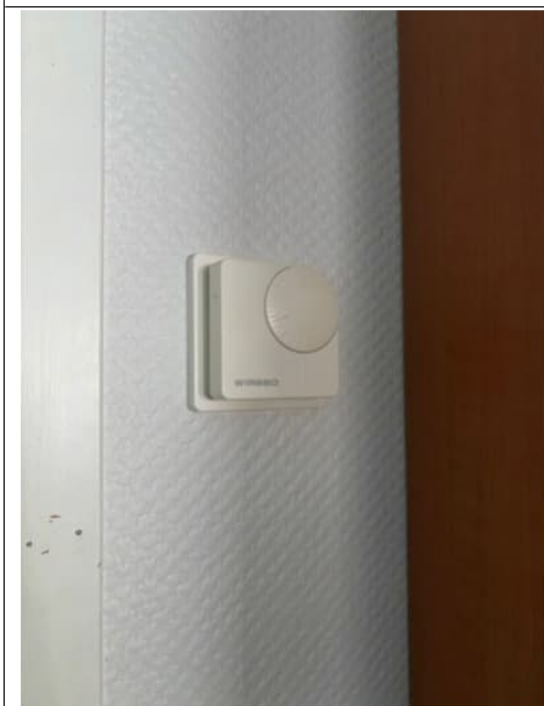
Kuva 66 Lämmön jakelun huoneisiin hoitaa vesi-kiertoinen lattialämmitys.
