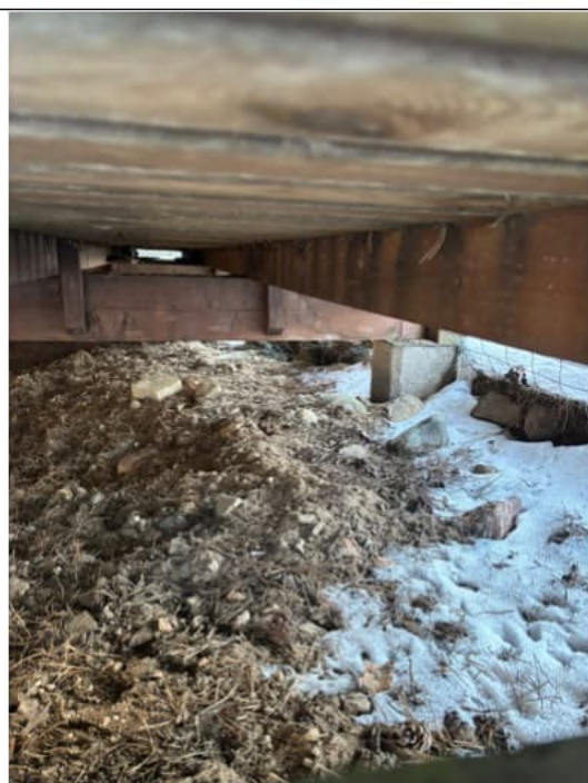
Kuva 25 Takapihan puurakenteinen terassi on perustettu pilariharkkojen varaan.
