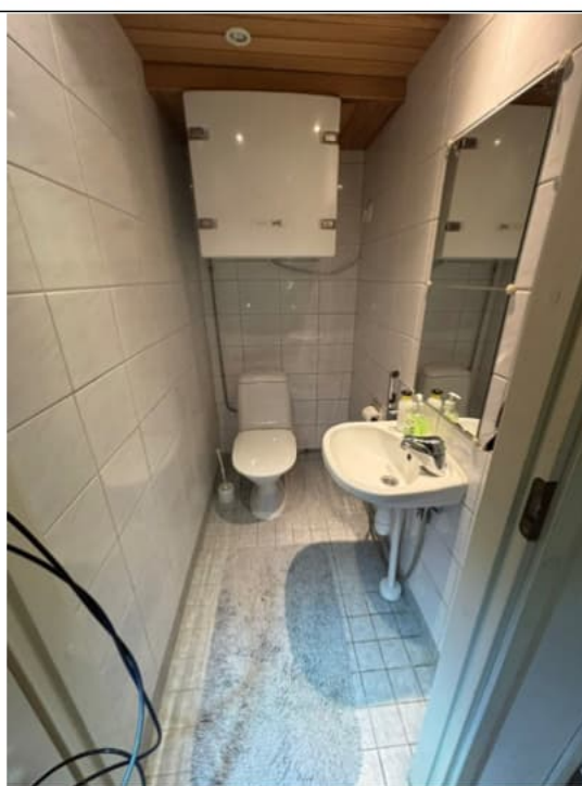
Kuva 52 Alakerran erillis wc on alkuperäiskunnossa ja se on rakennettu vuonna 2007. Kuntotarkastuksessa ei saatu havaintoa vesieristeestä.
