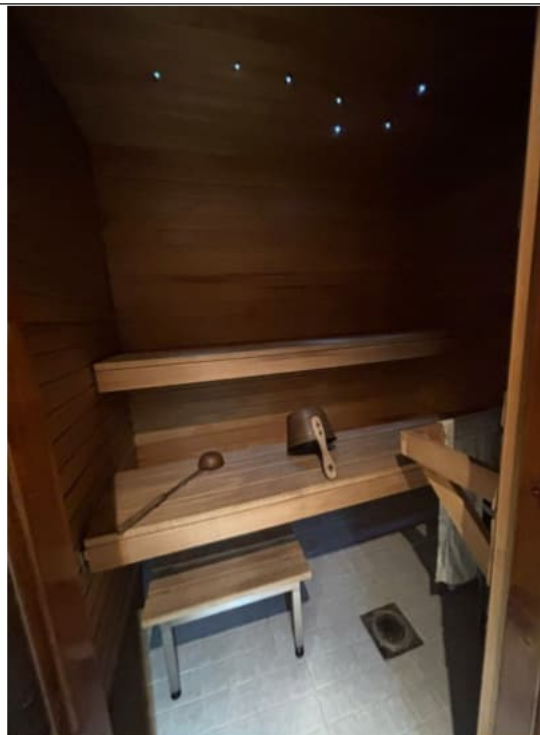
Kuva 28 Saunassa lattia on laatoitettu, seinät ja katto paneloitu. Sauna on alkuperäiskunnossa ja se on rakennettu vuonna 2007.
