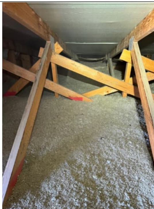
Kuva 9 Yläpohjan eristeenä toimi sellueriste.
