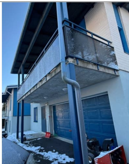
Kuva 23 Parveke on valettu betonista teräspilareiden ja harkkoseinän varaan
