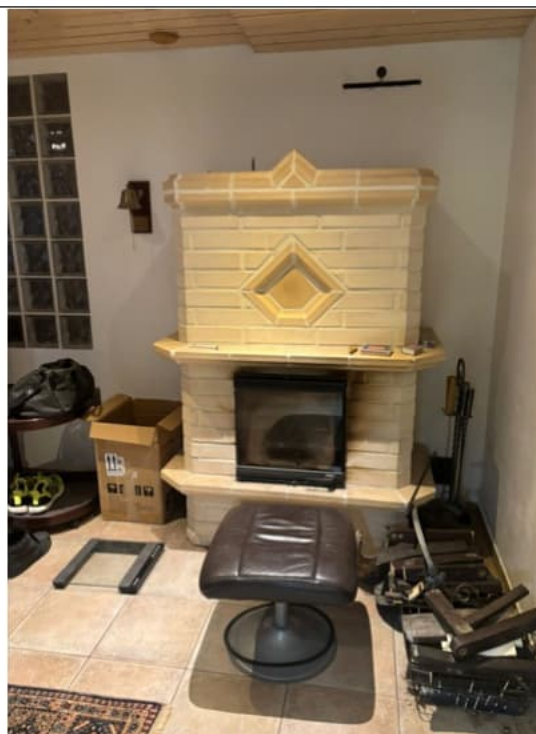
Kuva 65 Kellari kerroksessa on varaava takka.
