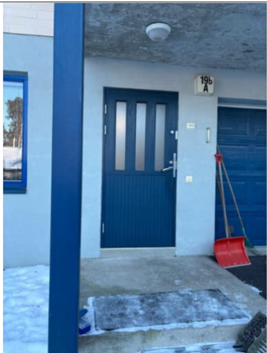
Kuva 22 Ulko-oven kunnossa ei havaittu poikkeamia.
