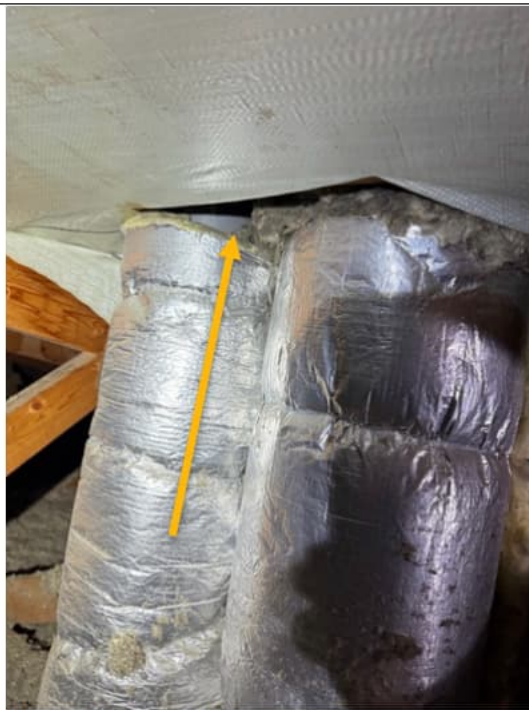
Kuva 12 Putkieristyksissä puutteita
