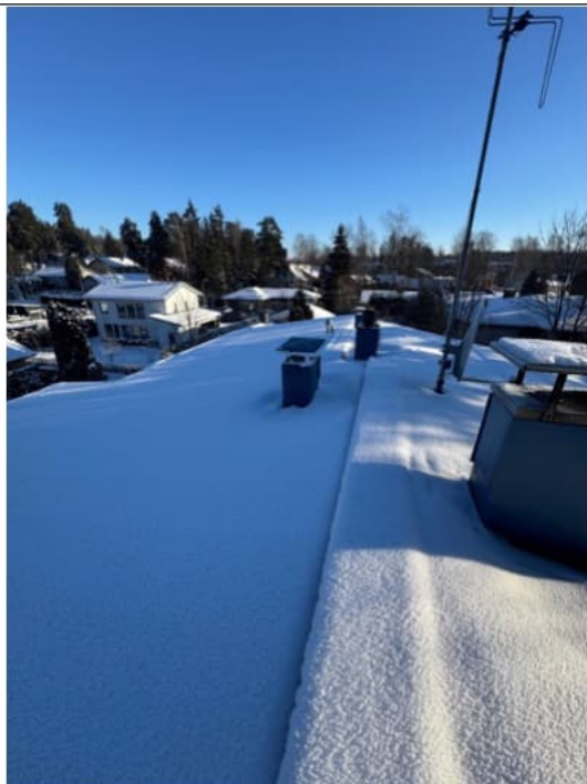
Kuva 8 Liesituulettimen huippumurin ja ilmanvaihdon poiston läpiviennissä ei havaittu poikkeamia.
