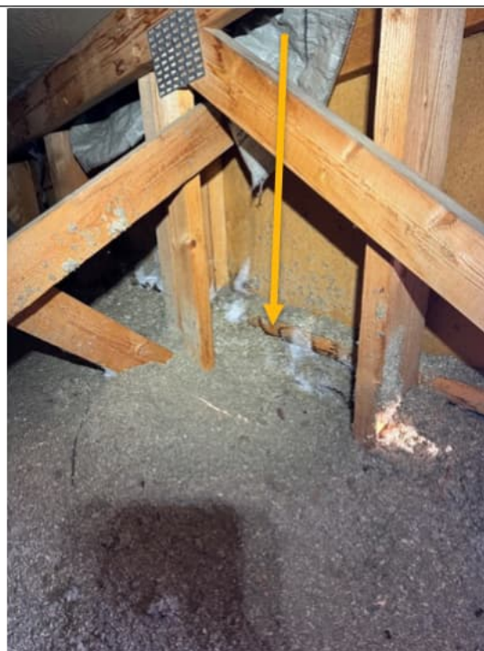
Kuva 15 Aluskate pääty päädyissä ja räystääslinjoilla seinän päälle
