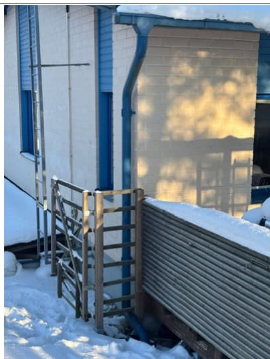
Kuva 5 Katon sadevedet oli kerätty syöksyistä kaivoihin. Sadevesien poistojärjestelmässä ei havaittu poikkeamia.
