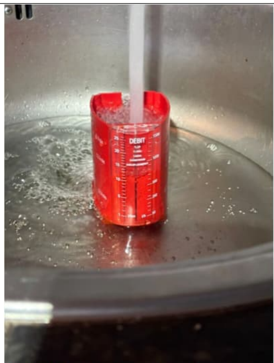
Kuva 76 Veden virtaama mitattiin ja havaittiin virtaaman olevan noin 12 litraa/min, joka on suositusten mukainen.
