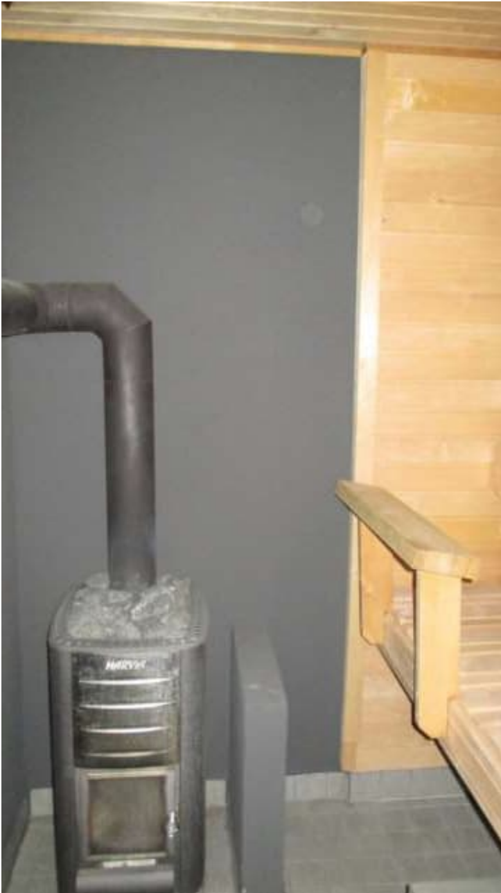
Liite 33. Kuvassa on kiinteistön sauna.
