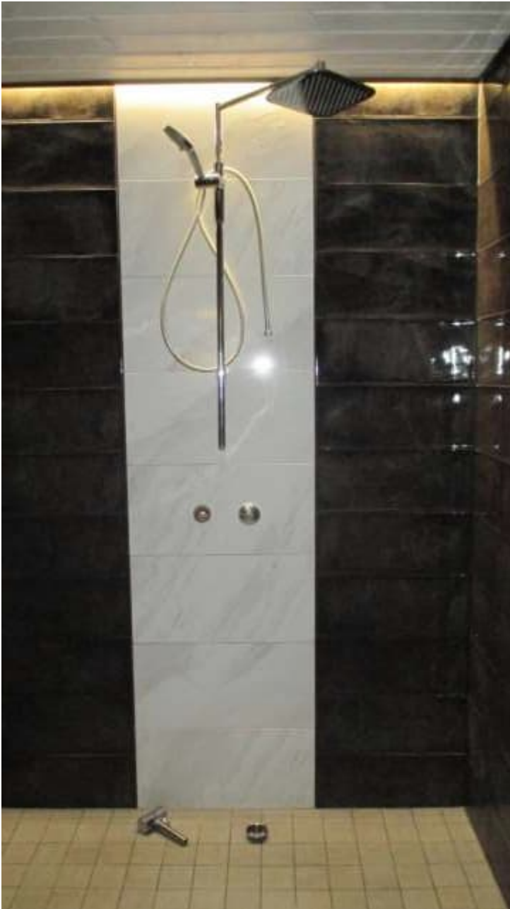
Liite 30. Kuvassa on kiinteistön suihku.
