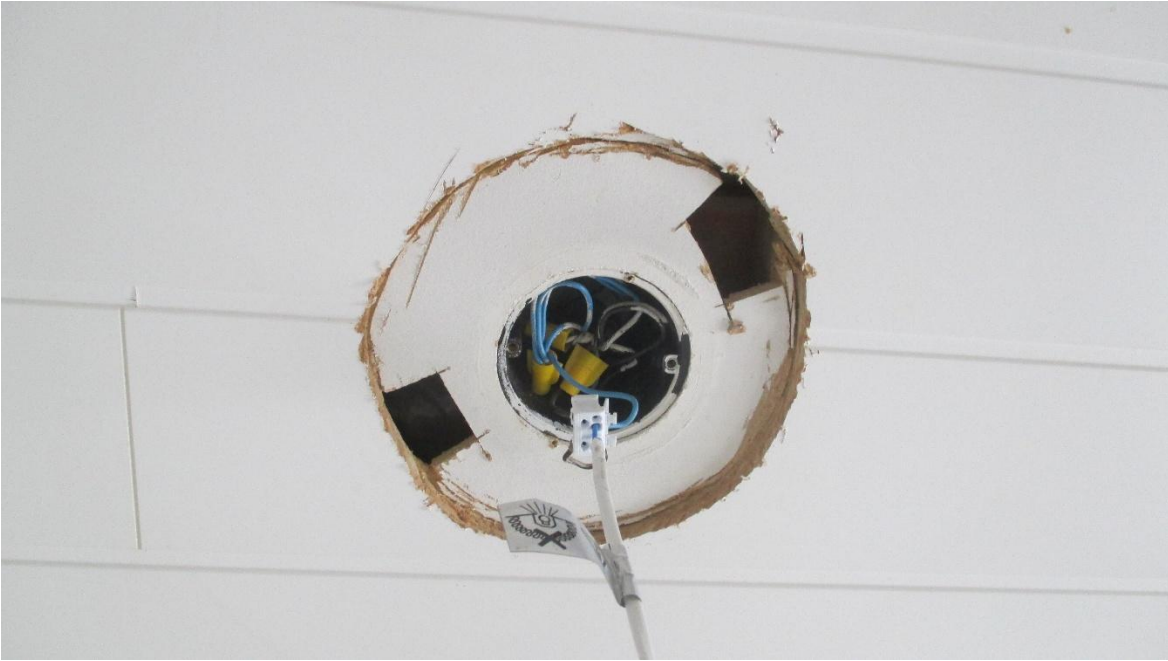
Liite 35. Kuvassa on kiinteistön keskeneräinen kattolampun sähköasennus.
