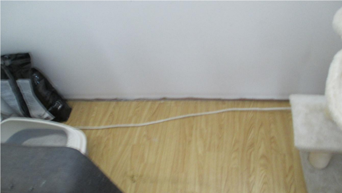
Liite 37. Kuvassa on kiinteistön huonetta, josta puuttuu jalkalistaa. Raoista voi nousta huoneilmaan ylimääräisiä hajuja.
