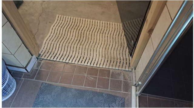
Oviaukossa ei ole tulvakynnystä, suihkunurkkauksen reunat on korotettu laatoilla.
