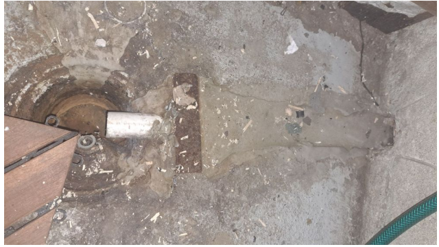
Lattiakaivo on valurautaa, kaivossa korokerengas. Kylpyhuoneen kaivolta tuotu poistoputki saunan kaivolle.
