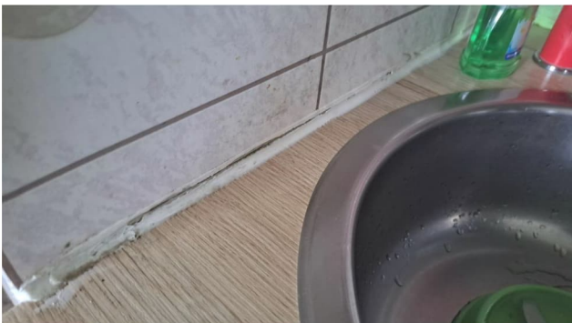
Silikonisaumat rakoilevat.
