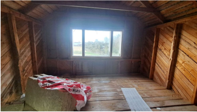
Vintillä on osa kylmää ullakkotilaa.
