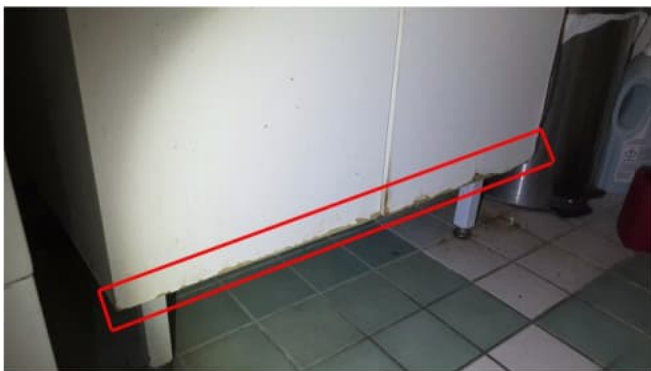
Allaskaapin etuovet vaurioitunut alareunasta.
