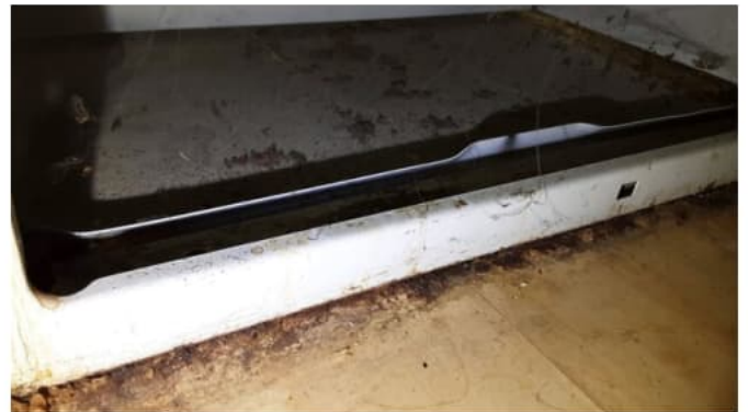
Jääkaapin alla betonipinta.
