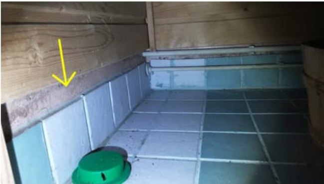
Laatoitus tehty muovimaton päälle.
