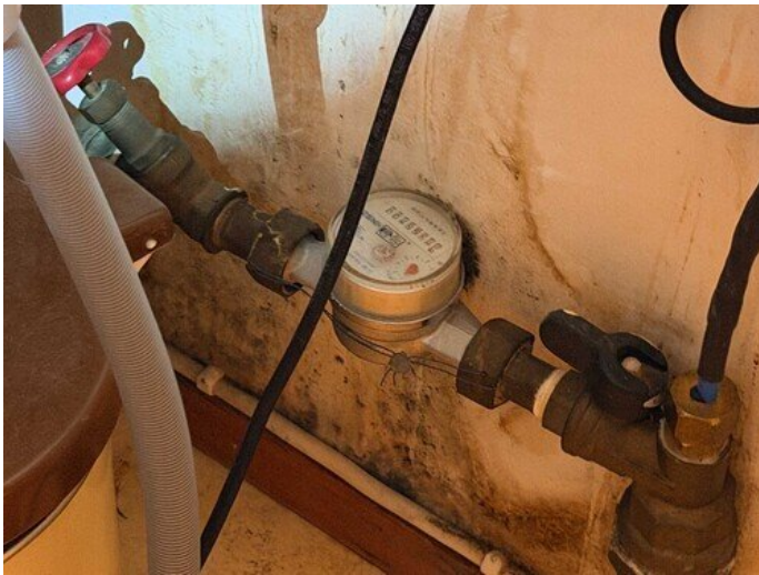
Kuva 14 Vesimittari
