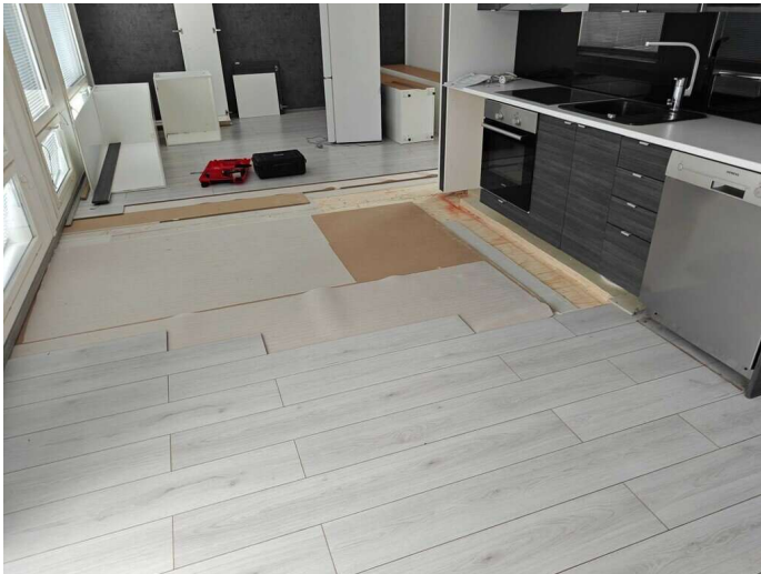
Kuva 17 Purettu alue lattiapinnoitteissa.
