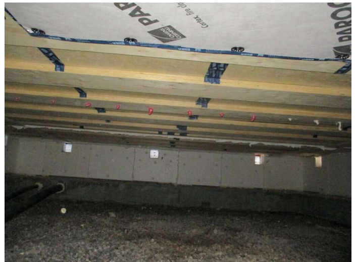
Kuva 10 Tuulettuva alapohja: Ei havaittu ongelmaa keittiön alapuolella.
