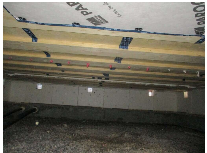
Kuva 10 Tuulettuva alapohja: Ei havaittu ongelmaa keittiön alapuolella.
