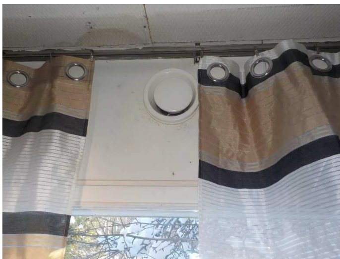
Makuuhuoneen ilmanvaihtoventtiili.
