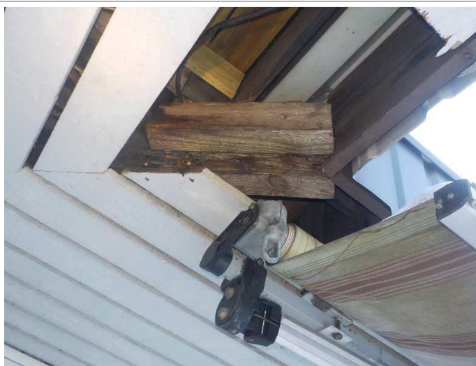
Purettua räystään aluslaudoitusta.
