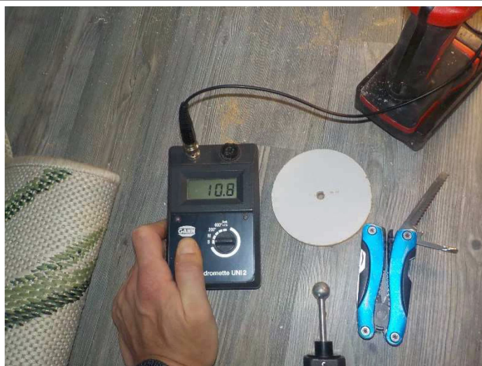
Väliseinän alasidepuun kosteuden mittaus.
