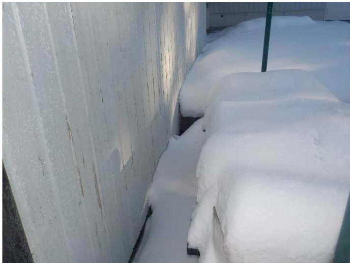
Autotalli-/varastotilan ulkoseinän alaosaa.
