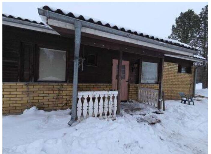
Kuva 6 Sadevesikourua ja syöksytorvea
