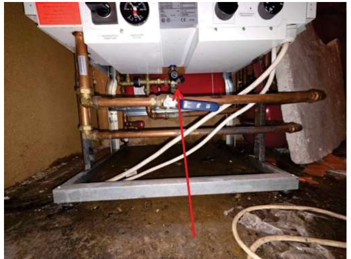
Kuva 30 lämminvesivaraajan tiikuvuoto
