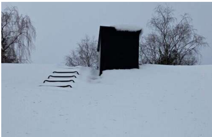
Kuva 14 Piippu ja kulkusilta
