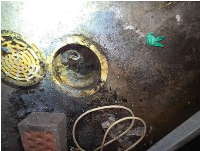
Kuva 29 Teknisen tilan lattiakaivo
