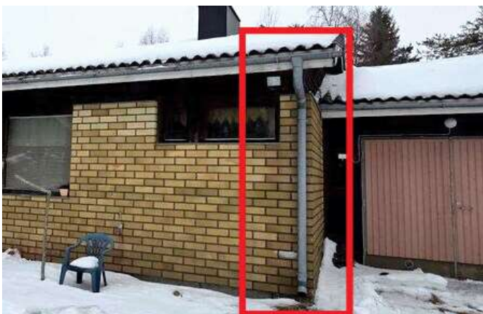
Kuva 7 Tiiliverhouksessa värimuutosta
