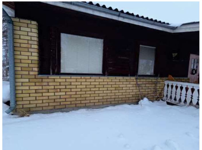
Kuva 2 Sokkelia ja julkisivua
