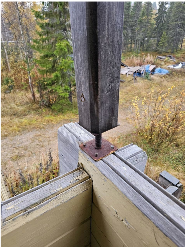
Ruosteinen säätöjalka, joka on naulattu huopanauloilla
