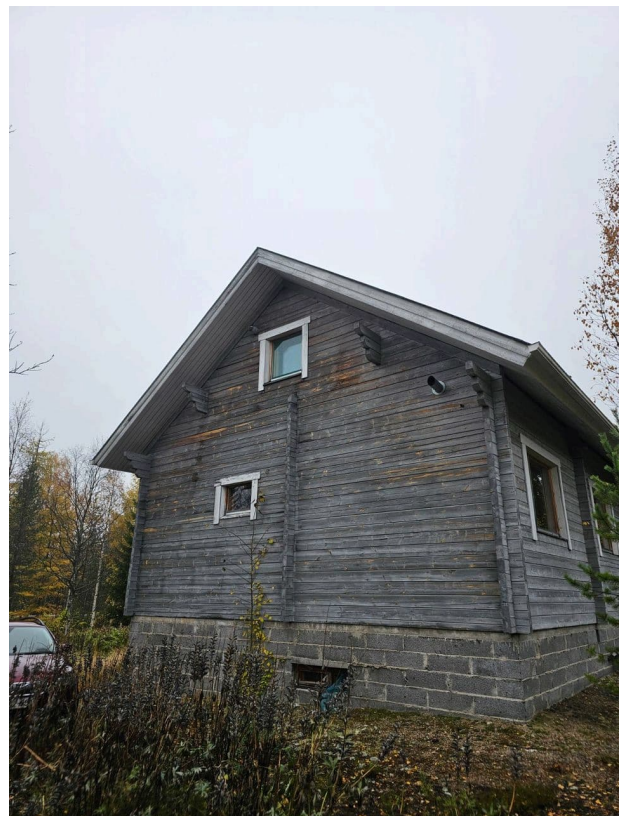
Epätasaisesta painumasta johtuva nurkkaliitoksen avautuminen
