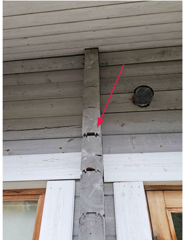
Epätasaisesta painumasta johtuva nurkkaliitoksen avautuminen
